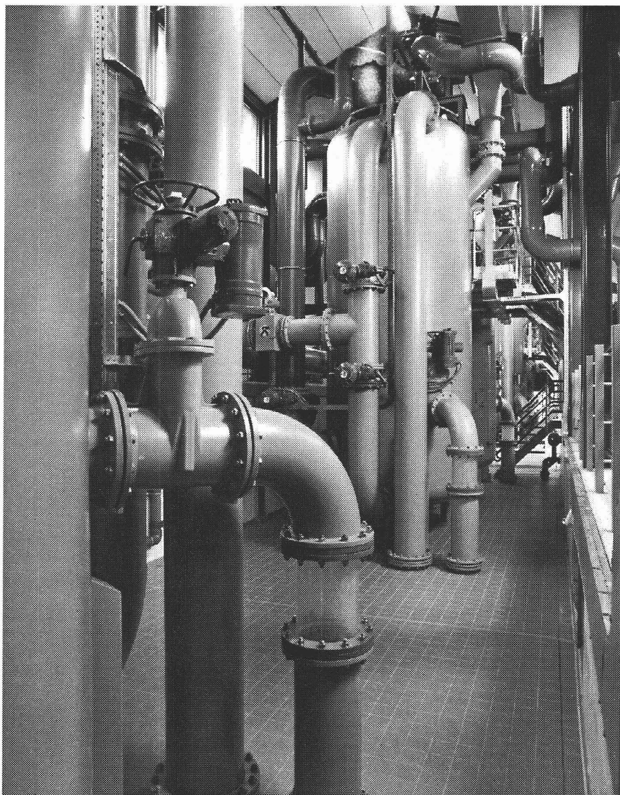
Afbeelding 4.4 Beluchtungs- en ontgassingstorens van de WOB te Veghel Foto WOB.
