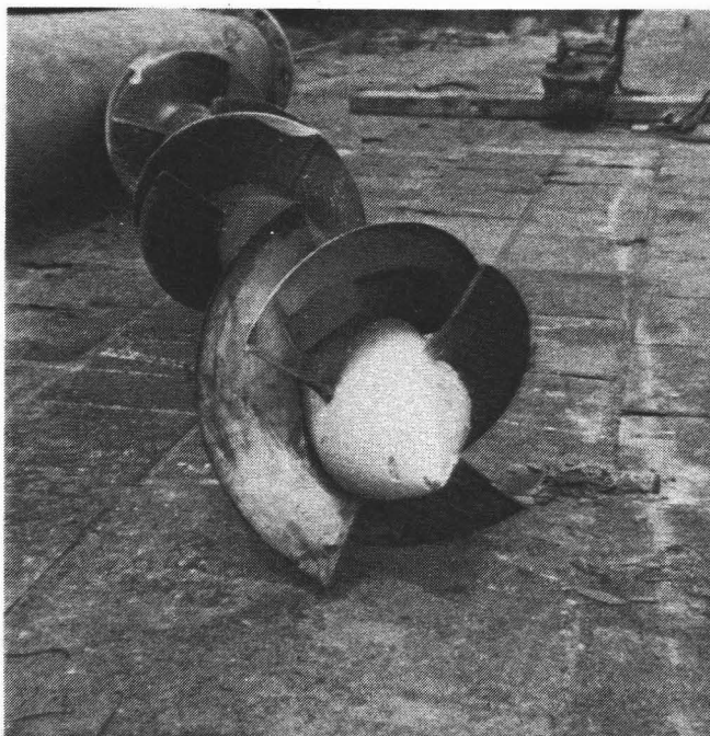
Afbeelding 7.3 Kort voor het kegelvormige deel van de statische menger wordt natronloog gedoseerd. Hierdoor is kalk afgezet. Pompstation Waalwijk
