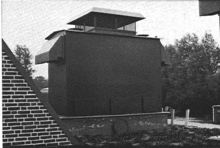
Afbeelding 3.7 Beluchtingstoren met meestroom beluchting. Pompstation Engelse Werk, W.M.O.
