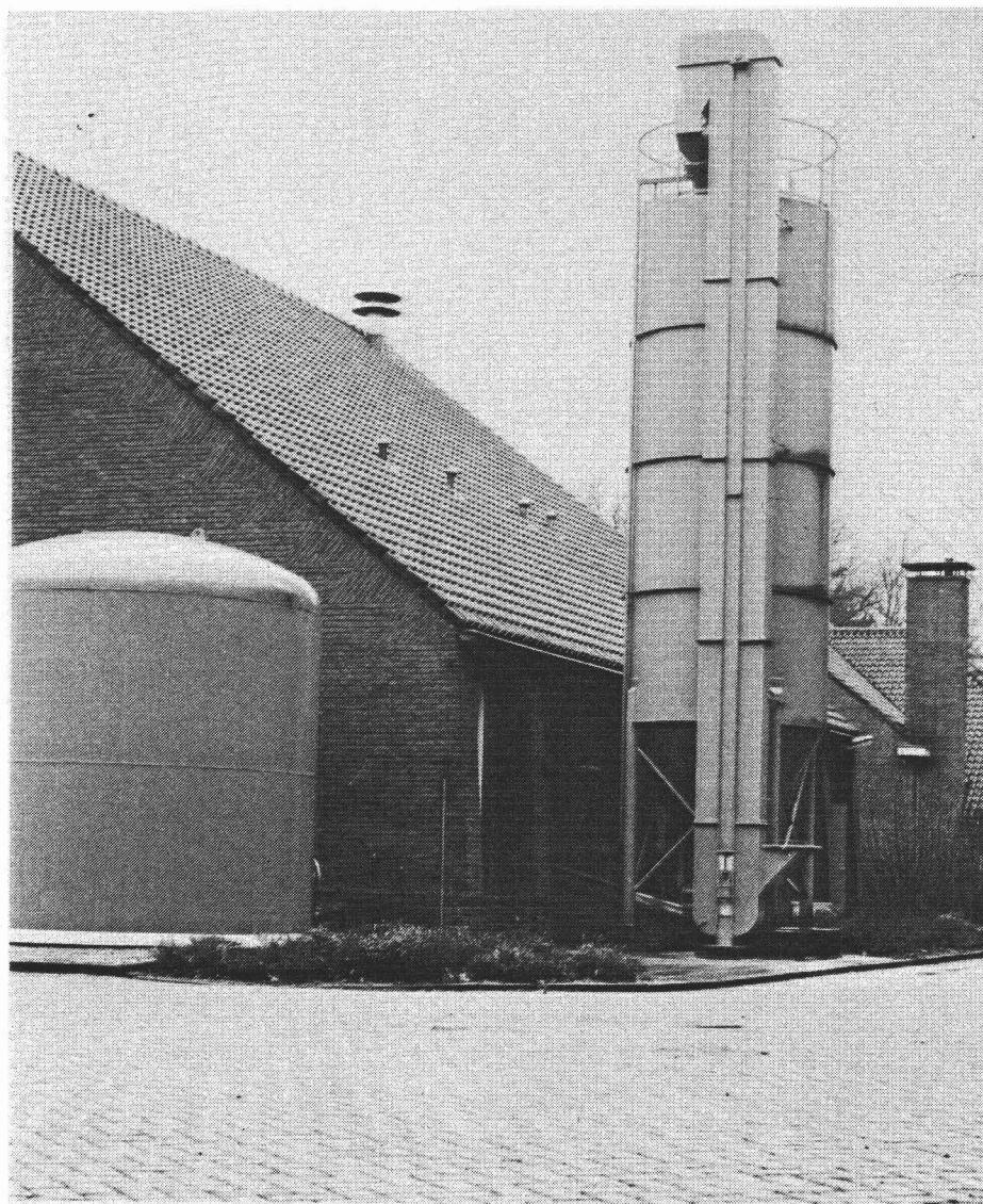
Afbeelding 5.1 Silo en filter voor dolomitisch filtermateriaal. Pompstation Heumensoord
