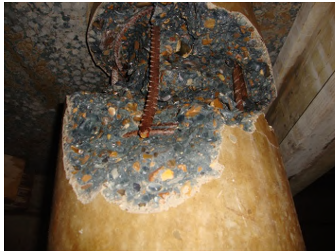
Foto 7 De gevolgen van het opdrukken van het dak van een reservoir (foto's PWN).
