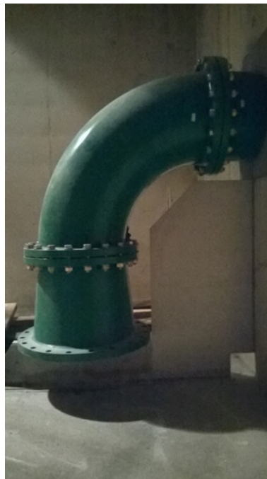
Foto 4 Aanzuigbocht met splitter (foto Pidpa).
