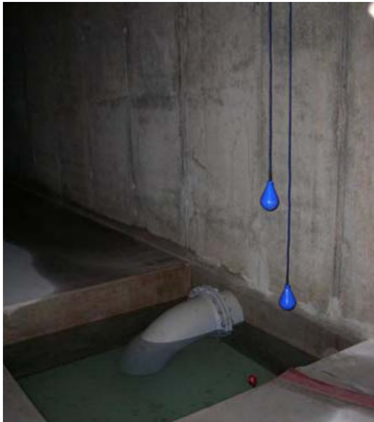
Foto 3 Zuigkuil met niveaumetingen (laag-water en laag-laag-water, LW en LLW).
