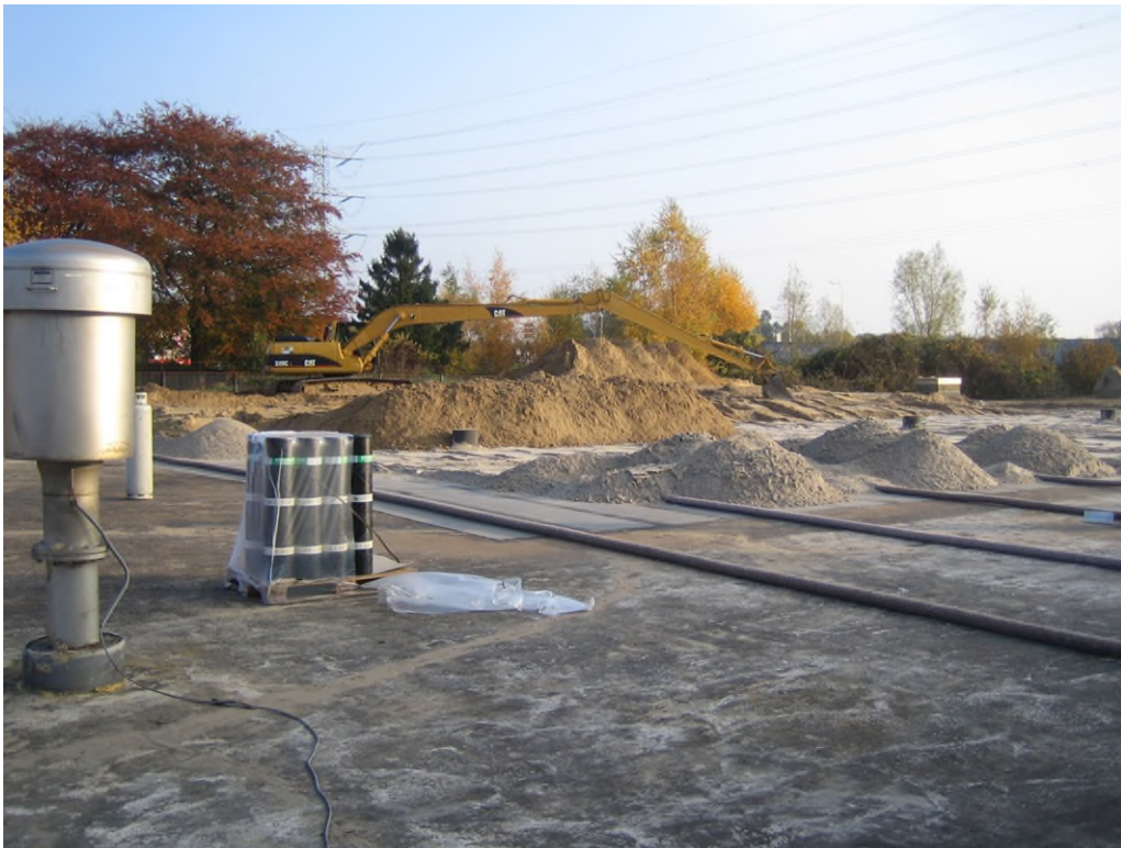
Foto 8 Dak van een drinkwaterreservoir bestaande uit dakbedekking (zand en grond moeten nog worden aangebracht).
