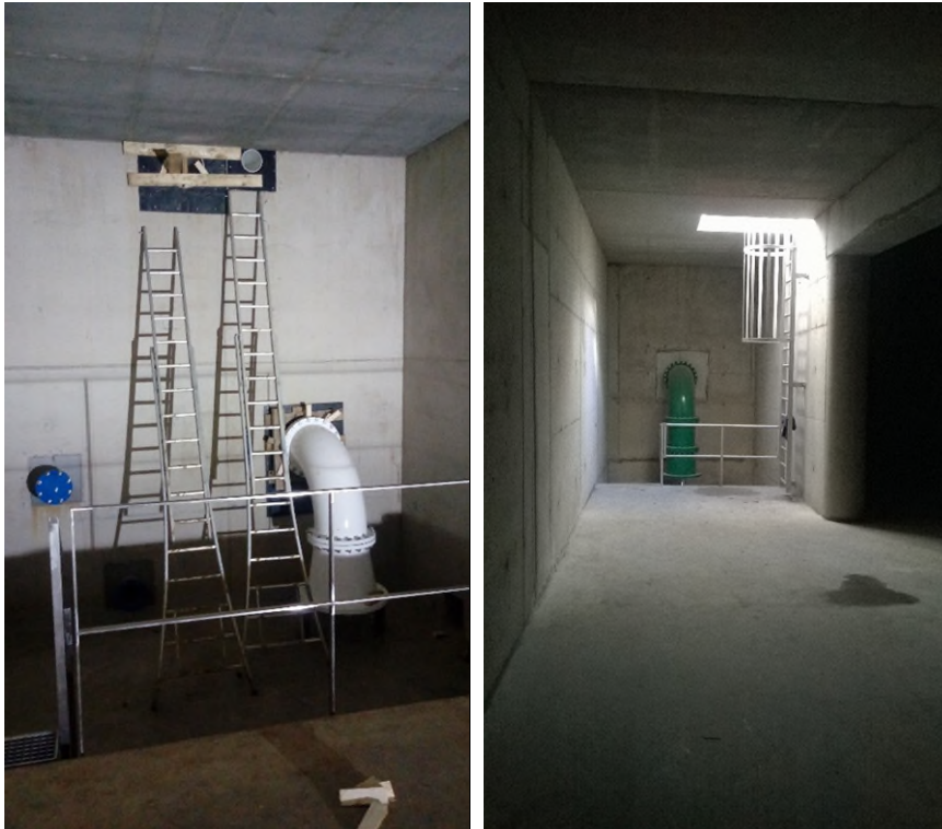
Foto 5 Zuigkuil in aanbouw (links) en afgewerkt (rechts) (foto's Pidpa).
