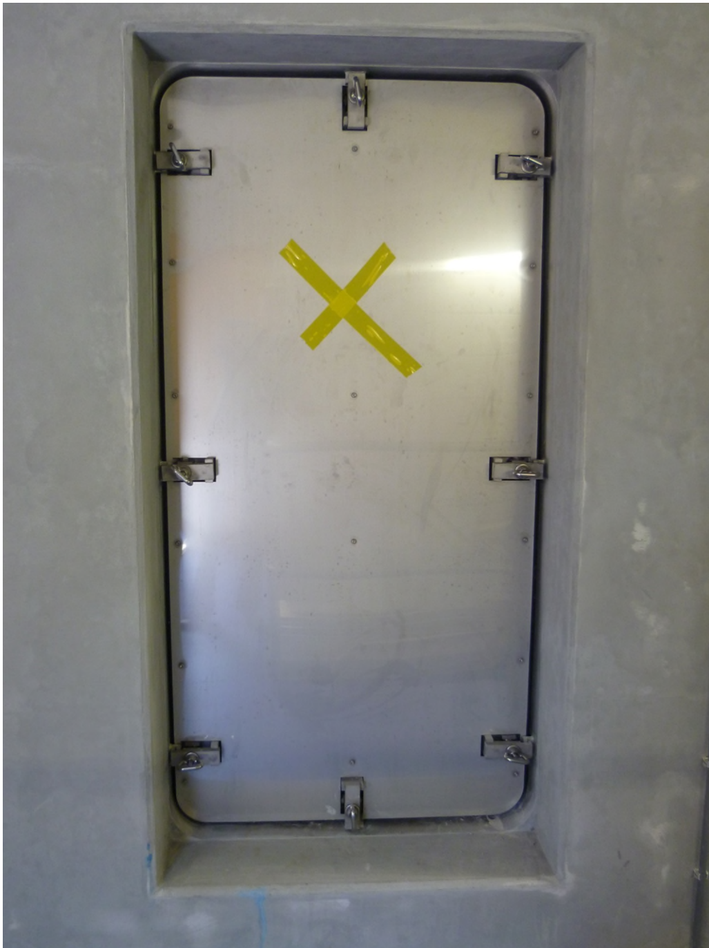
Foto 1 Waterdichte deur in een drinkwaterreservoir.
