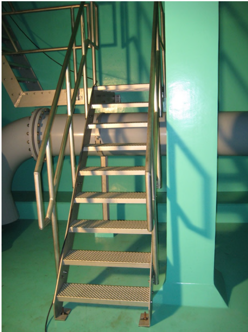
Foto 2 Roestvaststalen trap in een drinkwaterreservoir.
