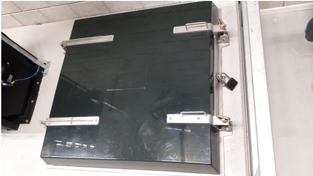
Foto 9 Volledig afsluitbaar RVS toegangsluik (foto Evides).
