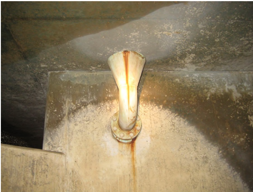
Foto 6 Praktijkvoorbeelden van een overloop van een drinkwaterreservoir (met hoogniveaumeting) (foto's van respectievelijk Vitens, Waternet en PWN).
