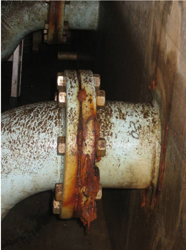
Foto 15 Corrosie van ingestort muurdoorvoerstuk.
