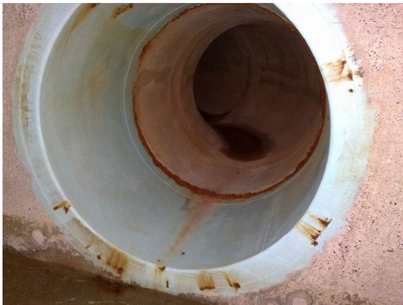
Foto 14 Beschadigde coating en corrosie aan ingestorte stalen doorvoer.
