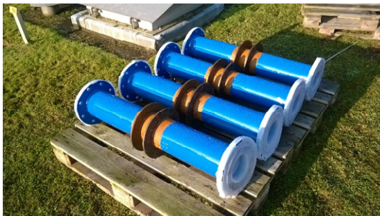
Foto 1 Nog in te storten doorvoerstukken op de het bouwterrein. De niet-gecoate delen van de buitenbuiswand en de lek- en verankeringsflenzen zijn nog zichtbaar (foto's Pidpa).
