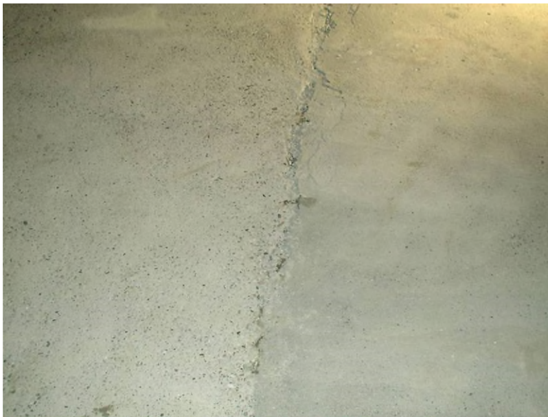
Foto 9 Onvlakheid ter plaatse van aangeheelde vloer.
