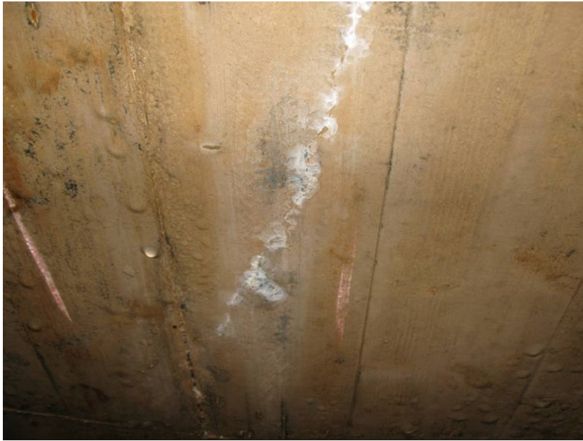
Foto 8 Kalkuitbloeiingen ter plaatse van scheurvorming in een dek.
