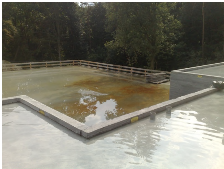
Foto 4 Testen waterdichtheid van het dak van een drinkwaterreservoir (foto Evides).
