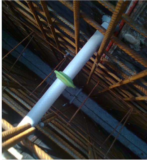
Foto 17 Dichtingsring uit zwelmateriaal op centerpenhuls (foto Pidpa).
