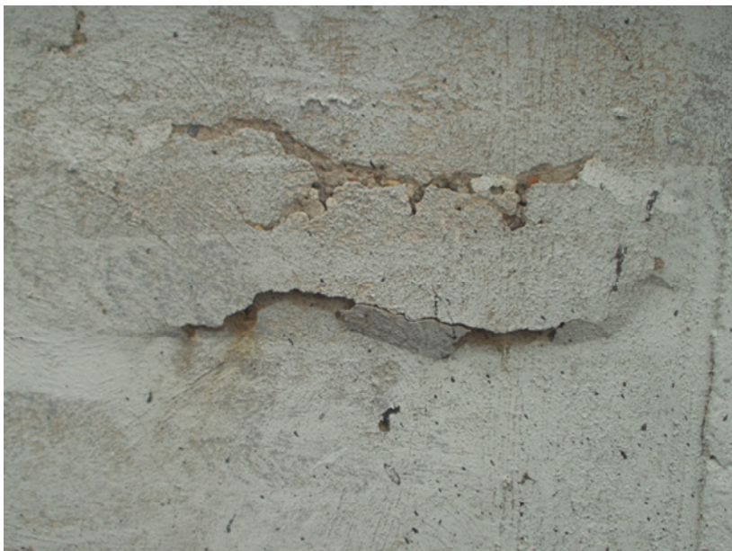
Foto 6 Afgedrukte betondekking (scholvorming) als gevolg van corrosie door onvoldoende betondekking.
