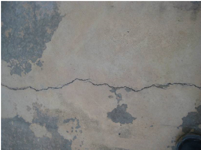
Foto 5 Scheurvorming in wandconstructie.
