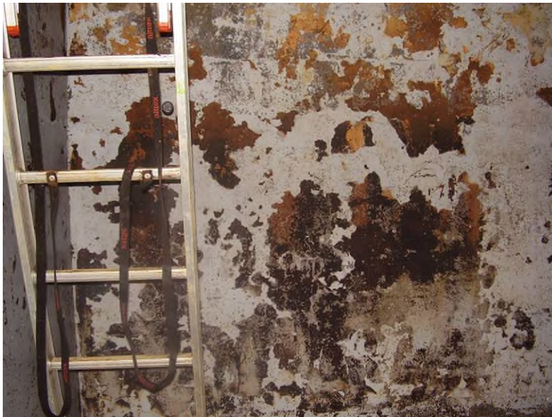
Foto 13 Beschadigde coating op wandconstructie als gevolg van erosie.
