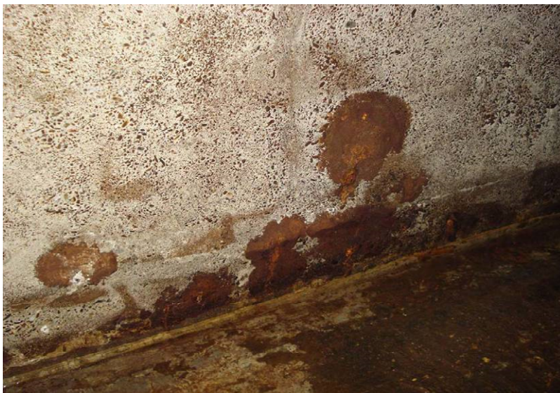
Foto 11 Biofilmvorming ter plaatse van vloer-wand aansluiting.
