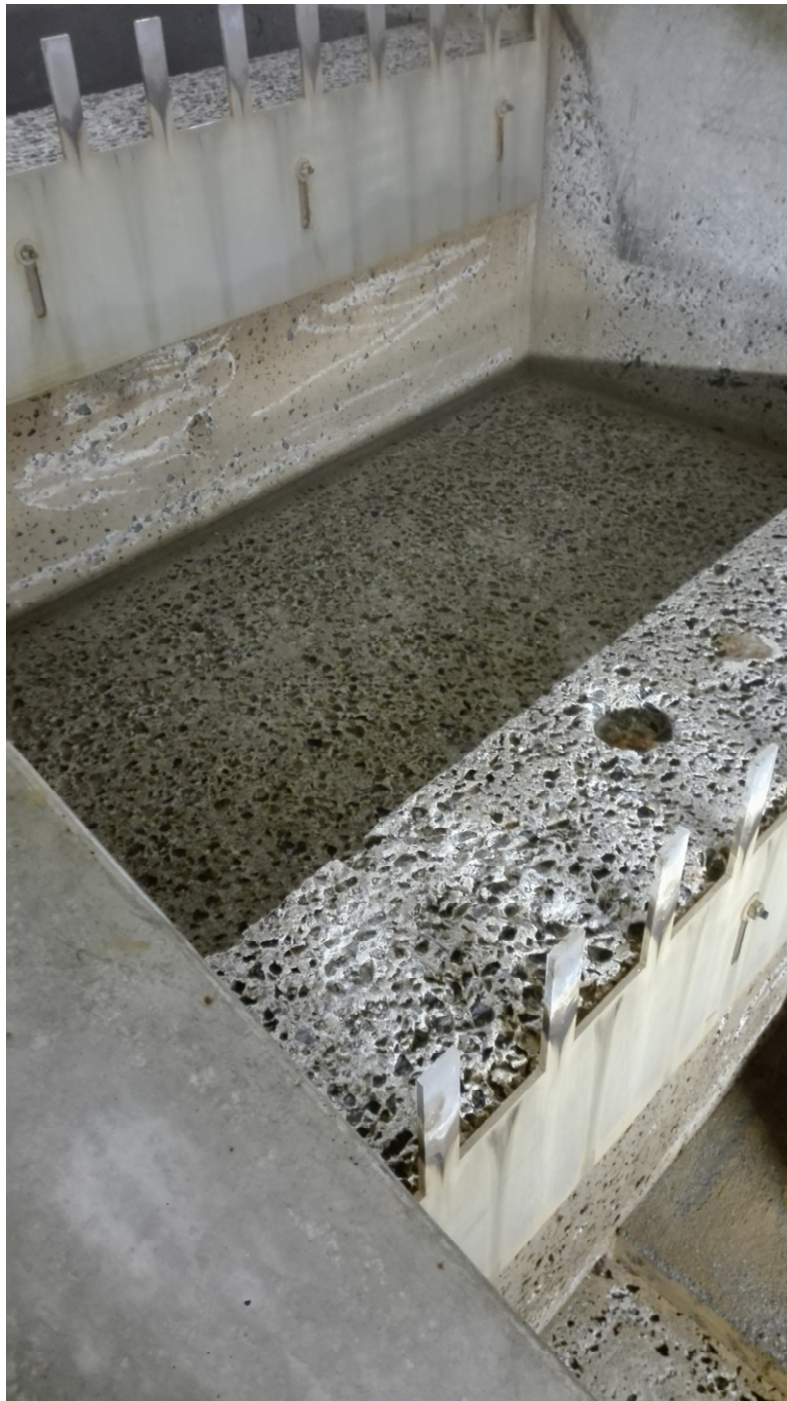
Foto 16 Aangetaste beluchtingstrap.
