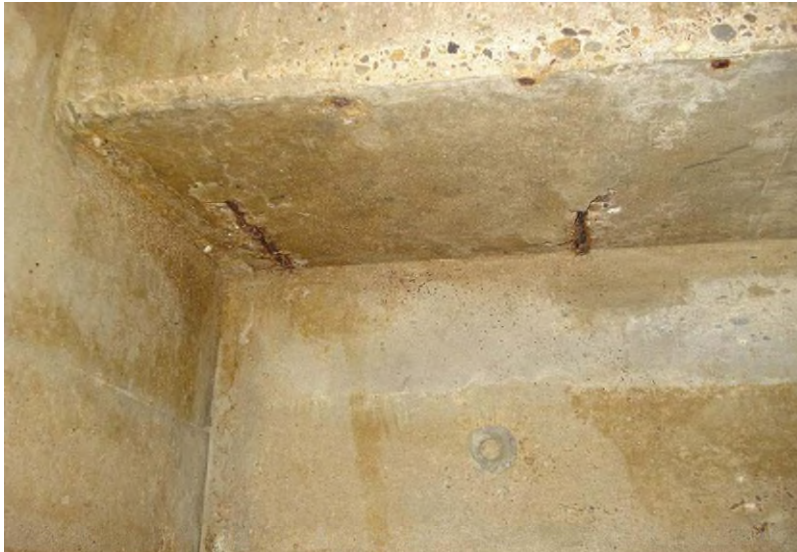
Foto 7 Plaatselijk corroderende wapening als gevolg van onvoldoende betondekking.
