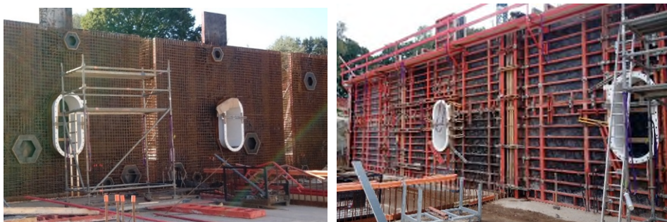
Foto 2 Wand van een drinkwaterreservoir in aanbouw, voor én na sluiting van de systeembekisting. Zowel rechtstreeks in te storten doorvoeren (witte ovale mangaten) als uitkistingen voor sparingen zijn toegepast. (foto's Pidpa).
