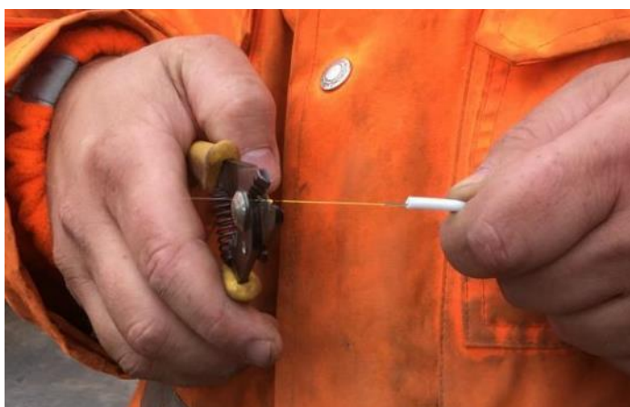
Figuur 2-9 De glasvezel kabel wordt hier geknipt en vervolgens geprepareerd voor gebruik.
