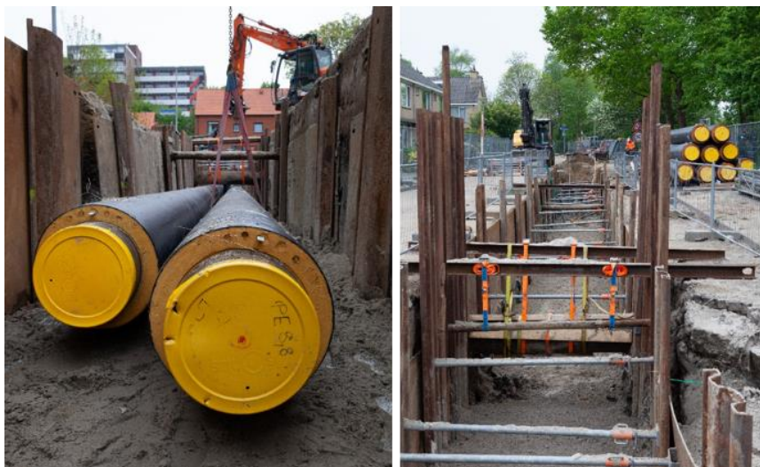
De aanleg van warmteleidingen (foto's: Waterbedrijf Groningen)
