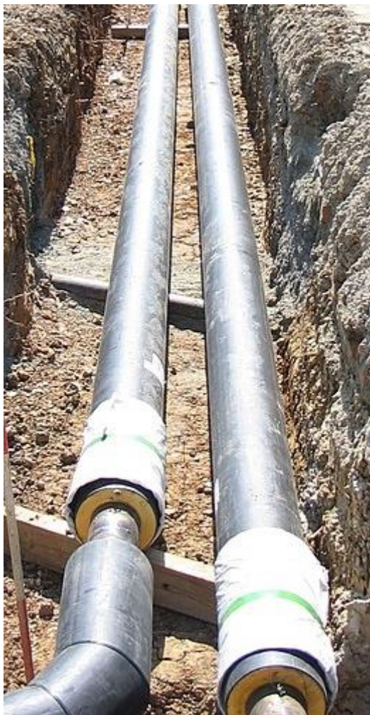
Figuur 2-4 Een warmtenet in aanleg.
