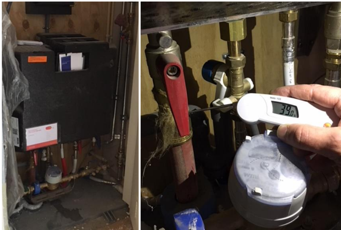
Figuur 3-3 Een temperatuur gemeten van 39°C in een meterkast, bron Jos Volleberg, WML.
