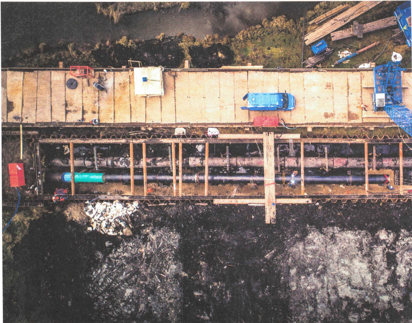
Aanleg transportleiding Waternet
