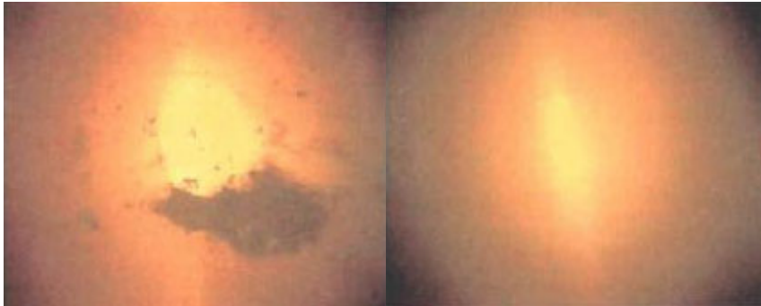
figuur 11 Opname van de leidingwand met de main trunk sampler (links voor het spuien, rechts erna)
