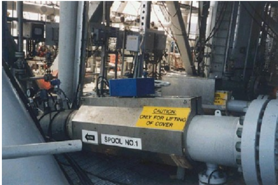
Afbeelding 3 : Online monitoring met FSM op een gasplatform in de Noordzee
