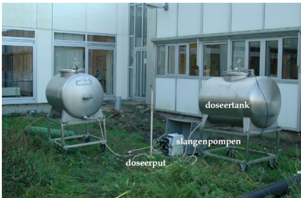
Figuur 3-2 Opstelling voor het doseren van een traceroplossing
