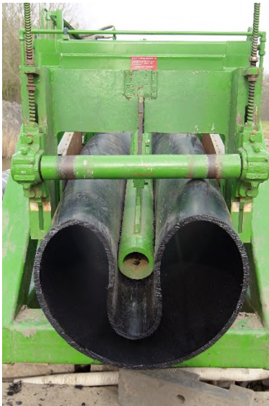
Figuur 11 Vouwen van een PE-liner. Foto gebruikt met goedkeuring van BAM Energie, Infra en Water.
