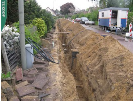
Figuur 4 Open sleuf in woonstraat.
