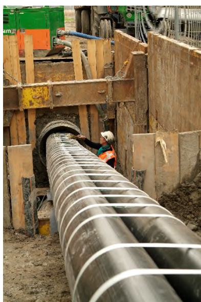
Figuur 10 Inbrengen van gevouwen PE-liner. Foto gebruikt met goedkeuring van BAM Energie, Infra en Water.
