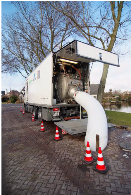
Figuur 8 Inbrengen van een kous. Foto gebruikt met goedkeuring van BAM Energie, Infra en Water (getoonde toepassing is niet op een drinkwaterleiding).
