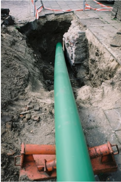
Figuur 6 Inbrengen PE-liner. Foto gebruikt met goedkeuring van BAM Energie, Infra en Water.
