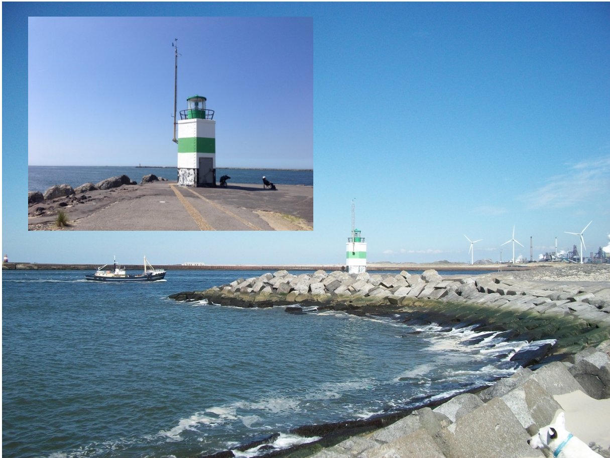
FIG. 1.2. De KNMI-windmast op de zuidpier van IJmuiden (foto Stuyfzand 2014). Locatie aangegeven op kaart Fig.1.1.
