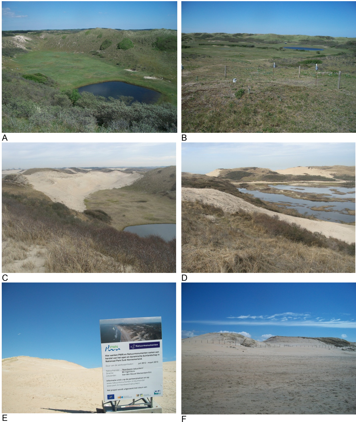
FIG.1.5. Het studiegebied vóór (A-B) en na (C-F) het kerven van de zeereep met 5 sleuven van 50-150 m breedte elk, en het strippen van de vegetatie en bodem van enkele duinhellingen achter de zeereep. A, C = Kattendel; B,D = Houtglop; E,F = zicht op de zeereep vanaf het strand op 30 april 2013. Foto's A, B, E, F door Stuyfzand, foto's C, D door Arens.
