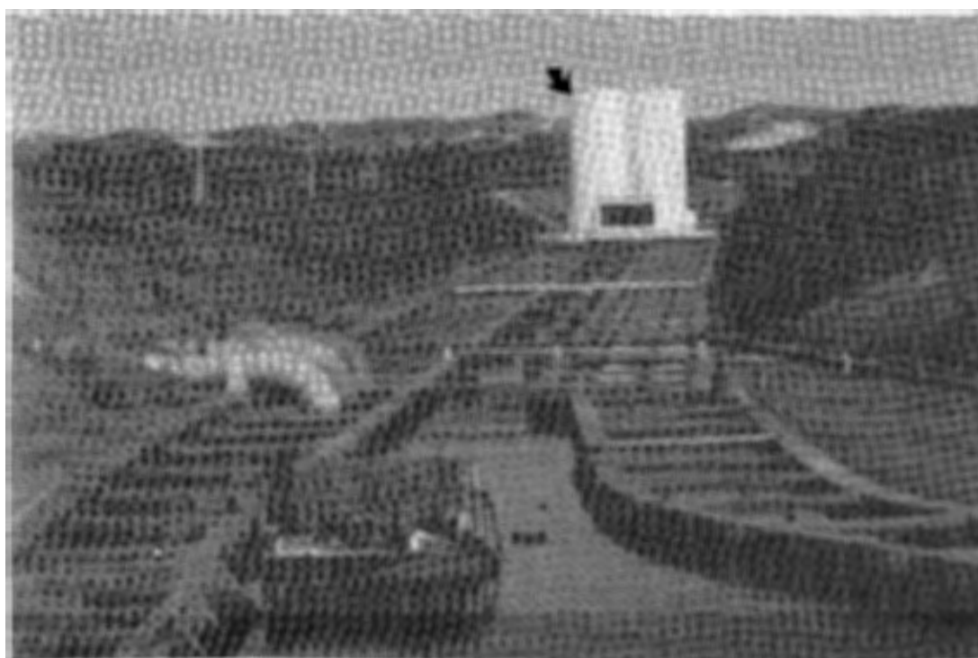
Fig. 10.3 - Het verzamelbekken van de DWL met de geïndiceerde kool- doserings, vlak waarachter zich het eindpunt van de duininfiltra- tie bevindt. (foto drs. E.A.I. Wanders, DWL)
