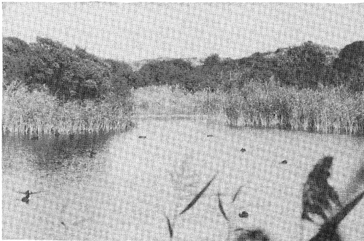
Figuur 2.8 - Een infiltratiepan van de Duinwaterleiding van 's-Gravenhage (foto: drs. E.A.J. Wanders; DWL)
