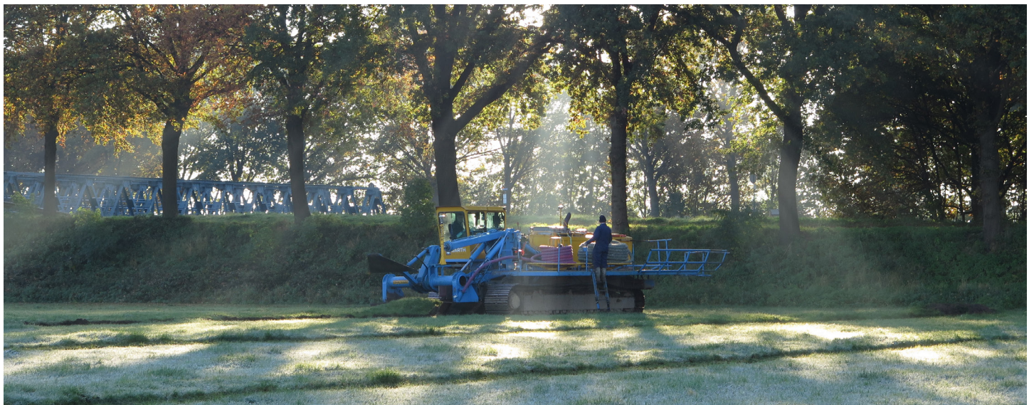
Aanleg van samengesteld drainagesysteem voor sub-irrigatie met gezuiverd restwater van Bavaria.
