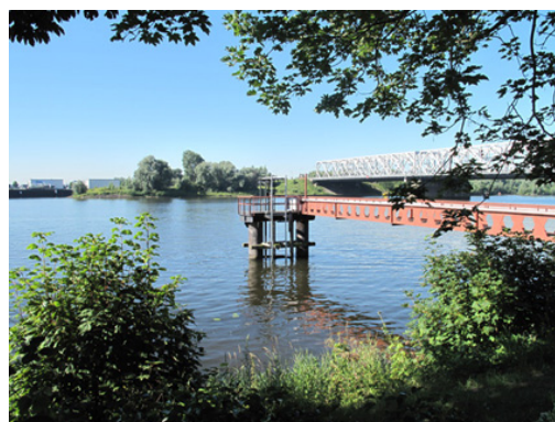
Afbeelding 4. Evides-RWS-monitoringstation te Keizersveer voor de waterkwaliteitsbewaking van het ingenomen Maaswater (wateronttrekking)
