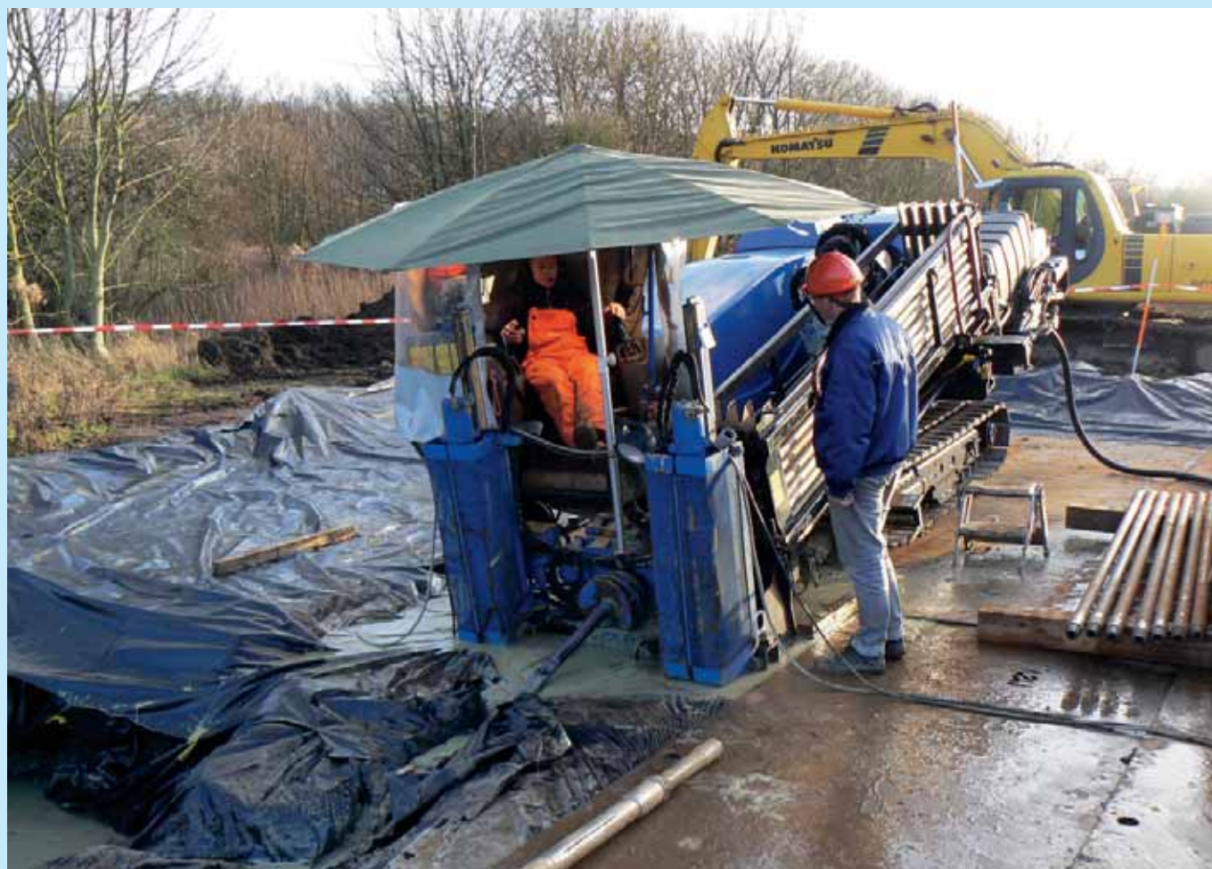
De boring in Nieuwegein, eind november.
