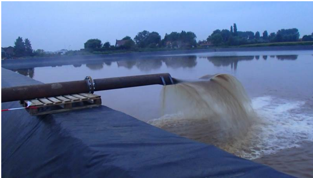
FIGUUR 4.5: VOORBEELD VAN EEN FOLIEBASIN VOOR DE TIJDELIJKE OPSLAG VAN ONTWIKKELWATER TIJDENS DE REALISATIE VAN EEN RECENT GEOTHERMIESYSTEEM IN NEDERLAND
