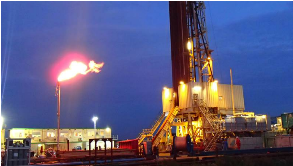
FIGUUR 2.1: VOORBEELD VAN EEN BOORLOCATIE TIJDENS DE REALISATIE VAN EEN RECENT GEOTHERMIESYSTEEM IN NEDERLAND. HET UIT HET FORMATIEWATER VRIJKOMENDE GAS, GROTENDEELS BESTAANDE UIT METHAAN, WORDT AFGEFAKKELD
