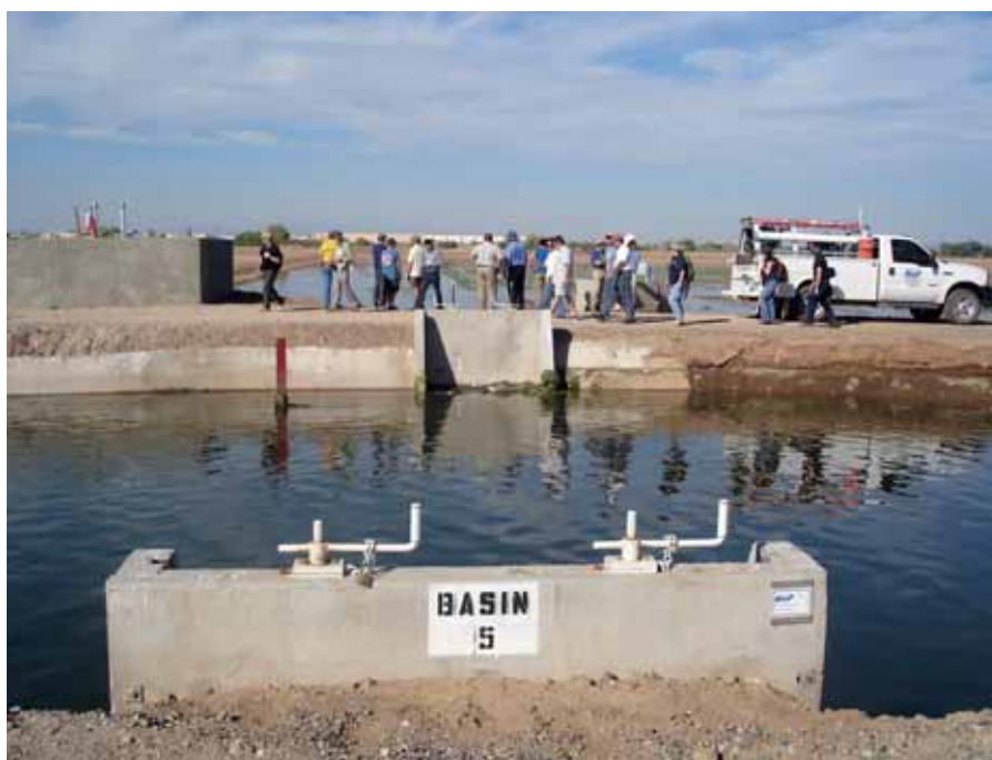
Een infiltratiepand bij Phoenix.
