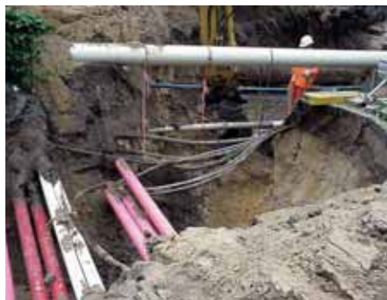
Werkzaamheden aan kabels en leidingen brengen niet alleen risico's op schade aan kabels en leidingen met zich mee, maar ook gevaren voor persoonlijk letsel.
