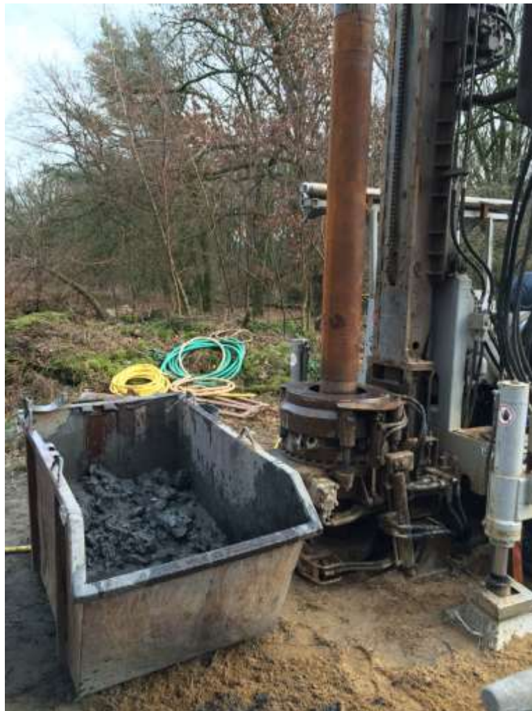
Figuur 3-1 Een booropstelling in het Montferland (foto Vitens).
