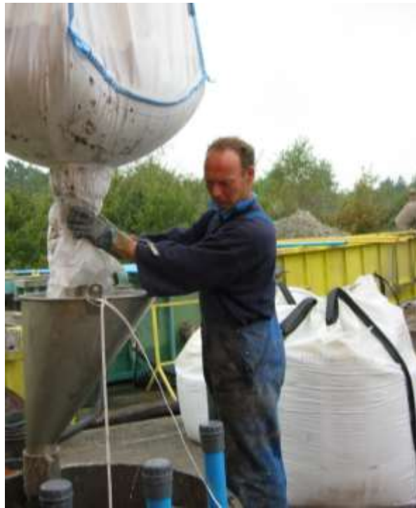
Figuur 3-3 Aanvullen van een winput (foto Brabant Water).
