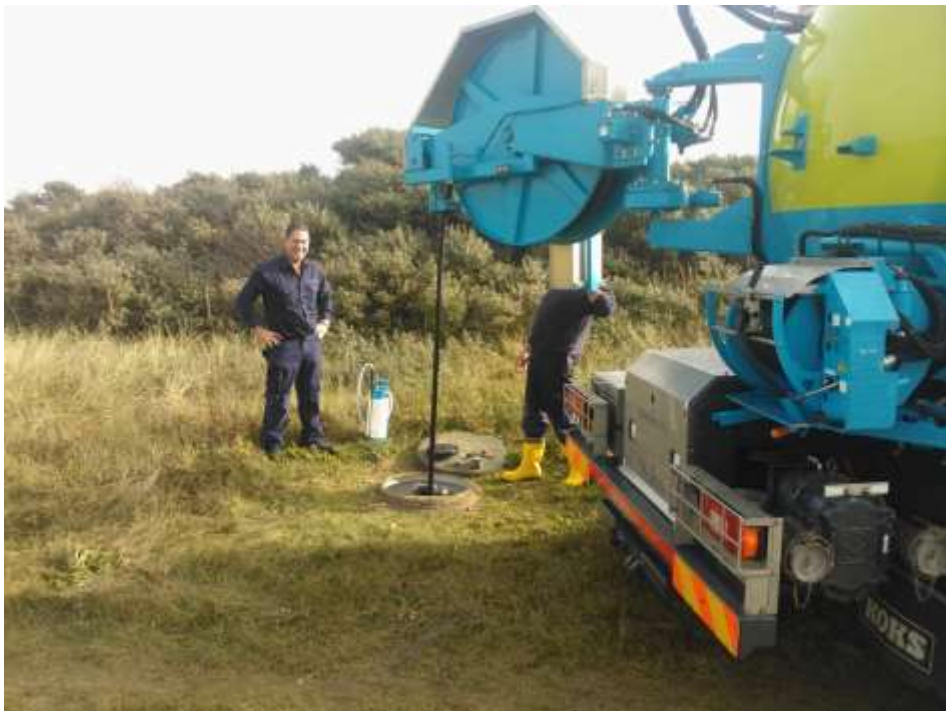
Figuur 5.1 Reinigen van winput. Achteraan staat een sproeier met desinfectiemiddel om de slang en sluitkop te reinigen (foto PWN).
