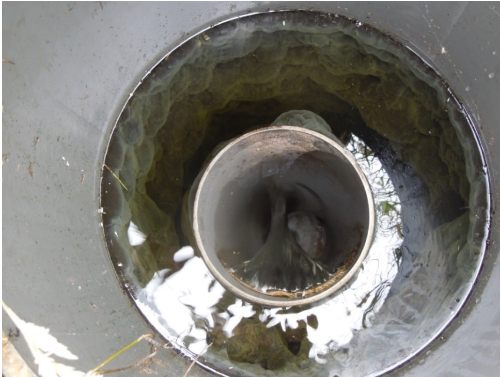
Figuur 3.7: Biofilmvorming in het KAD-systeem ('regelput').
