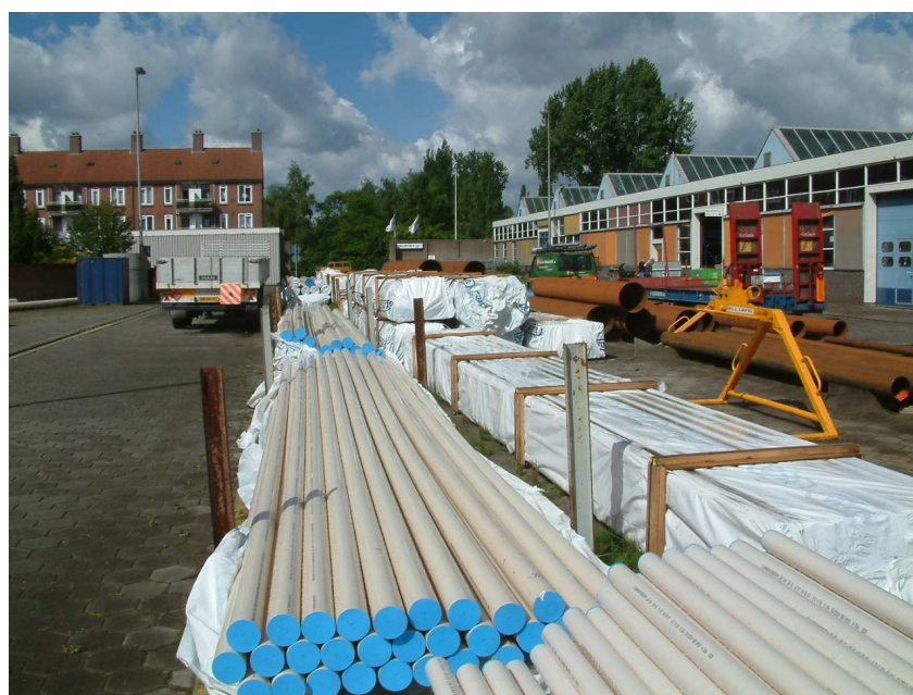
3.3.1 Buizen met stofkappen (doppen) en afdekkfolie.
