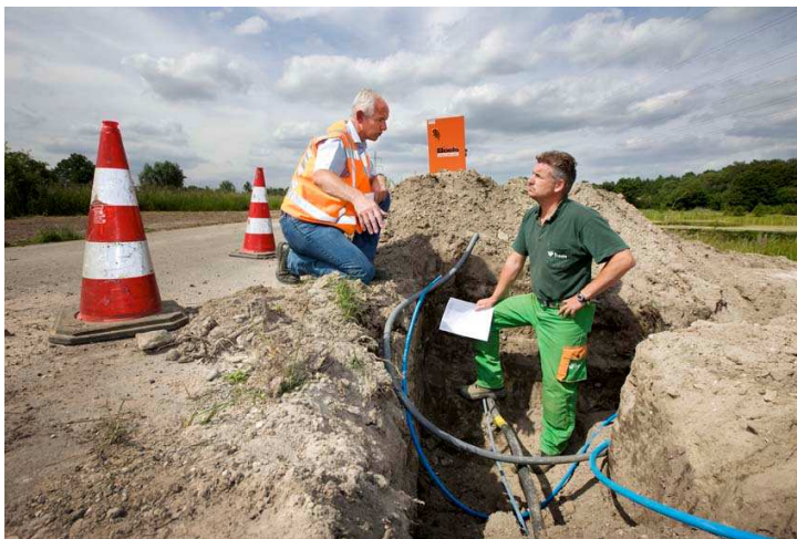
3.6.5 Werken in een droge werkput.
