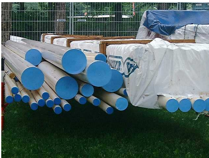
3.5.4 Bescherming van leidingmaterialen tijdens opslag op de werklocatie.
