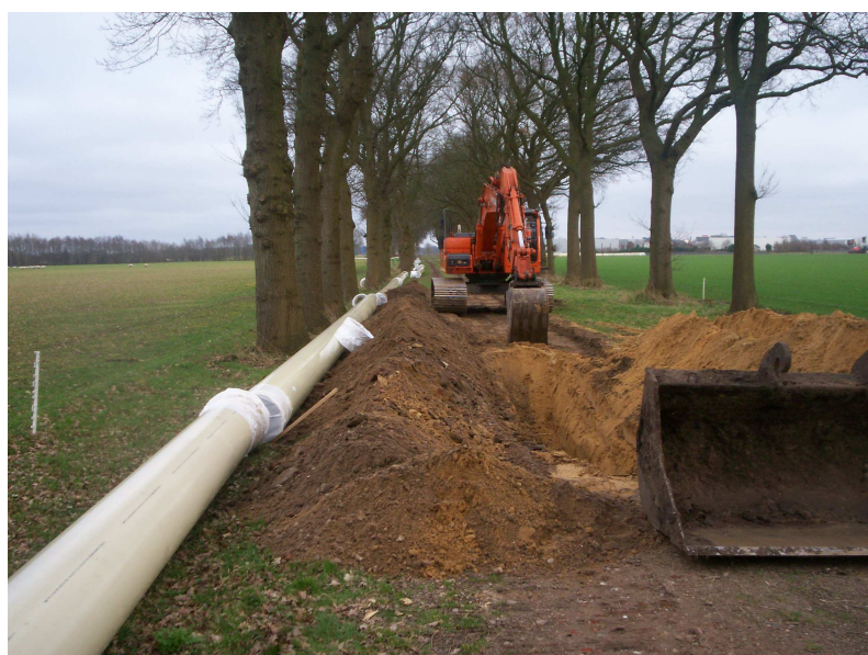
3.5.7 Bescherming van leidingmaterialen tijdens aanleg.
