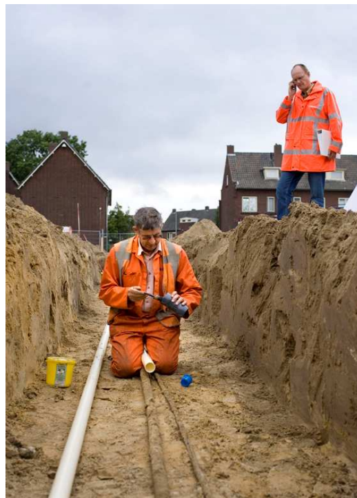
3.6.12 De aanleg van een leiding volgens richtlijnen van het drinkwaterbedrijf.
