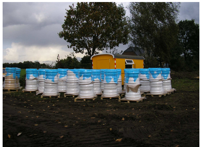
3.5.2 Bescherming van leidingmaterialen tijdens transport (zo NIET dus).
