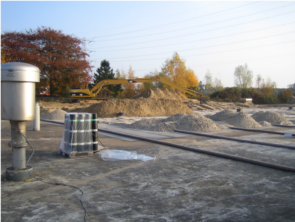
Figuur 8 Dakbedekking van een drinkwaterreservoir.
