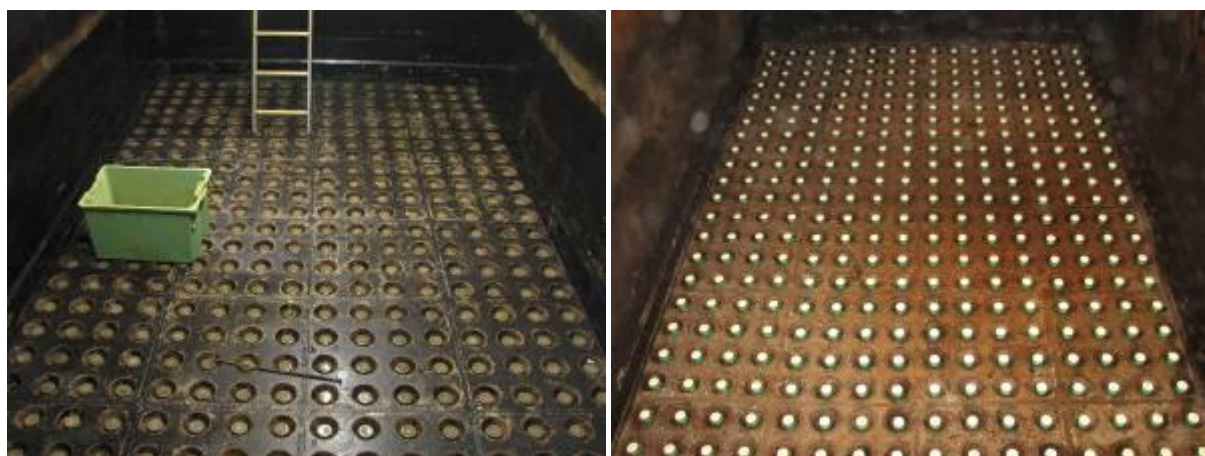
2.7 Het vervangen van de filterdoppen op een grondwaterpompstation (effectzone rood) valt in risicoklasse IV (foto WML).
