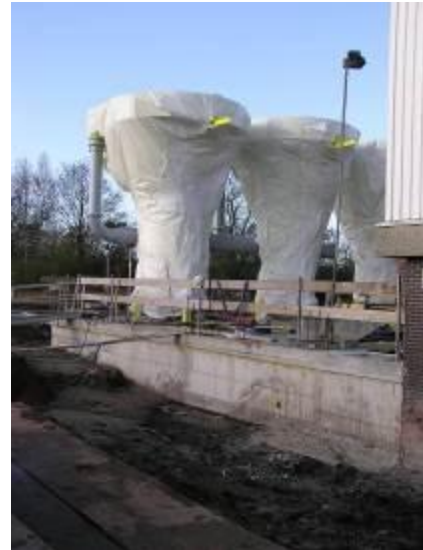
2.2.6 Inbouw van ingepakte pelletontharders op een productielocatie (foto's Vitens).
