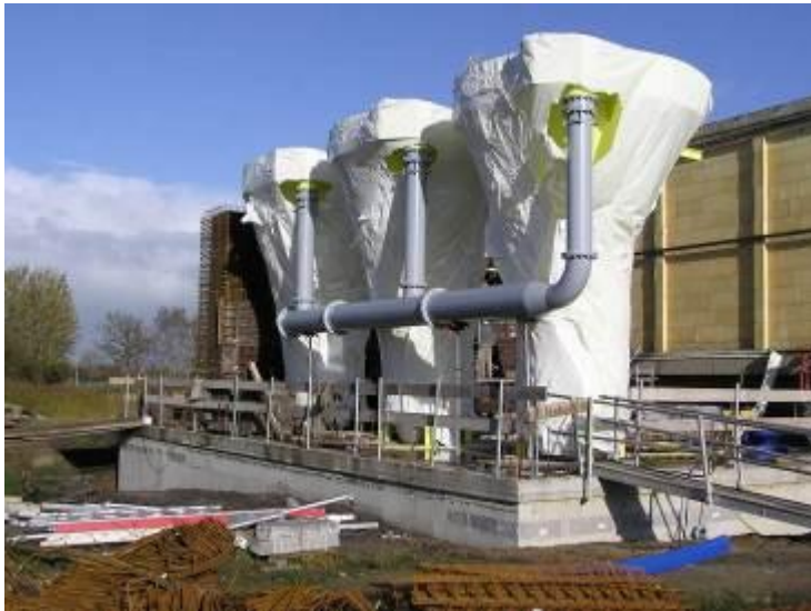
2.2.6 Inbouw van ingepakte pelletontharders op een productielocatie (foto's Vitens).
