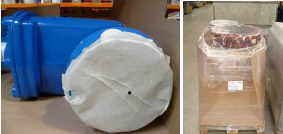
2.3.1 Controleer de verpakking van de te installeren onderdelen (foto's Vitens).
