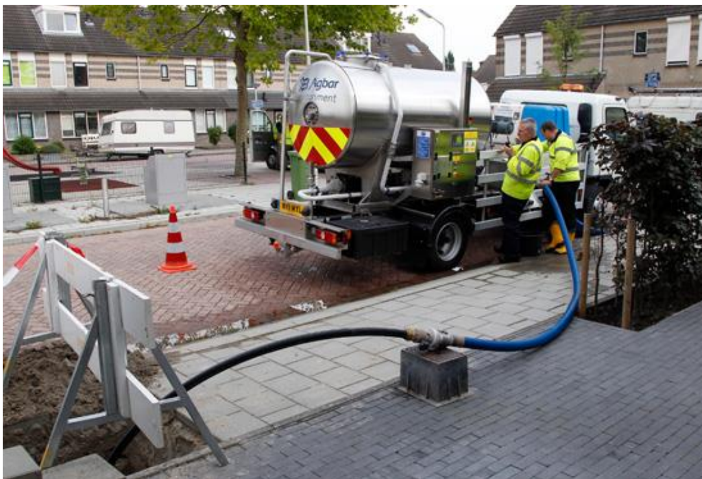
Figuur 32 Schoonmaken van leidingen door middel van ice pigging, injectie van de ijsslurrie (foto Oasen).
