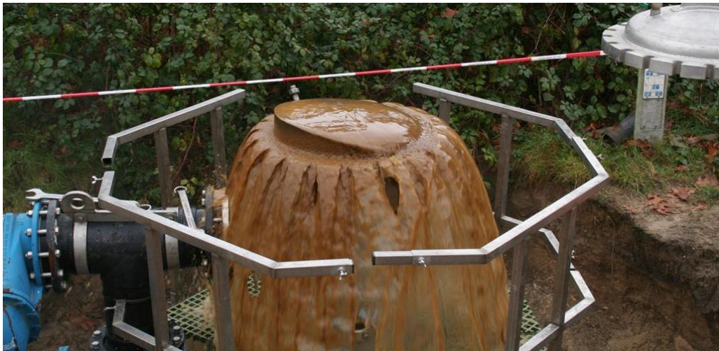
Figuur 37 Moderne ontvangst van een zachte prop (ø 800 mm) (foto WML, pompstation Heel, ruwwaterleiding).
