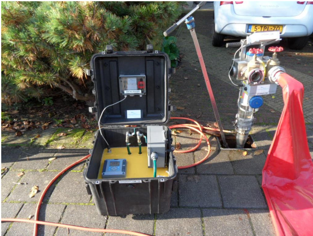
Figuur 26 Spuiactie door middel van waterspuien. Op de brandkraan zijn een 'spuizak', troebelheidsmeter en een volumestroommeter aangesloten (foto Dunea).
