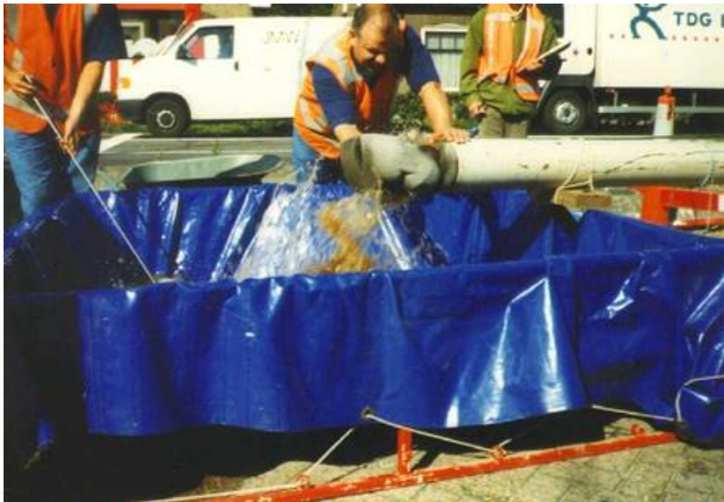
Figuur 36 Traditionele ontvangst van een zachte prop (Ø 300 mm) (foto Brabant Water, destijds WOB).
