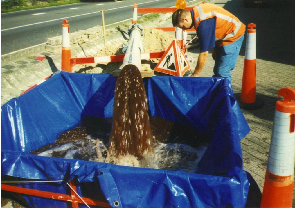
Figuur 31 Spuiactie door middel van proppen op een grotere diameter ( \varnothing 300 mm). De foto is genomen net voor de prop op dit punt uittreedt (foto Brabant Water, destijds WOB (< 2002)).
