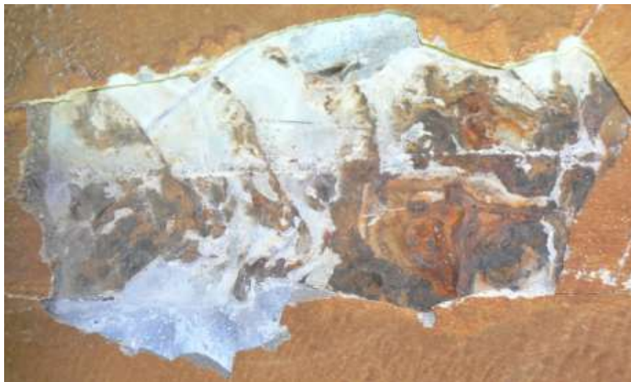
Figuur 9 Staaloppervlak onder de verwijderde aangesmeerde bekleding die is weergegeven in Figuur 8.
