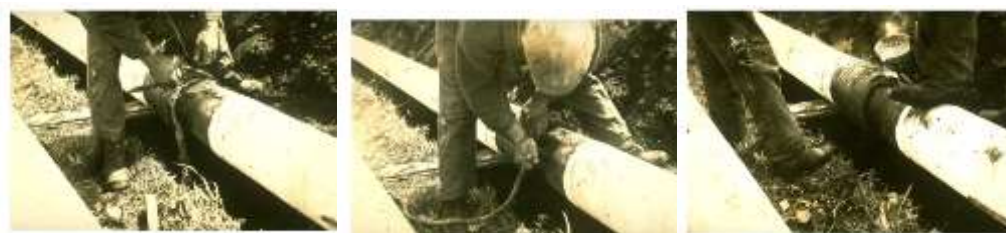
Figuur 12 Aanbrengen van een lood-striktouw verbinding [53].
