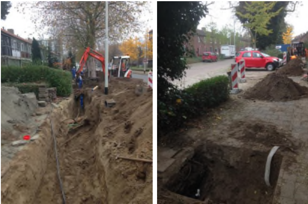
FIG. 2.2. WERKZAAMHEDEN BIJ BRABANT WATER, BREDA.
