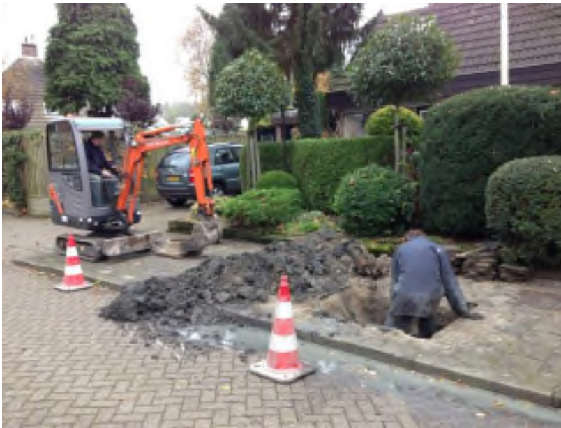
FIG. 2.4. WERKZAAMHEDEN BIJ DUNEA, BERGSCHENHOEK.
