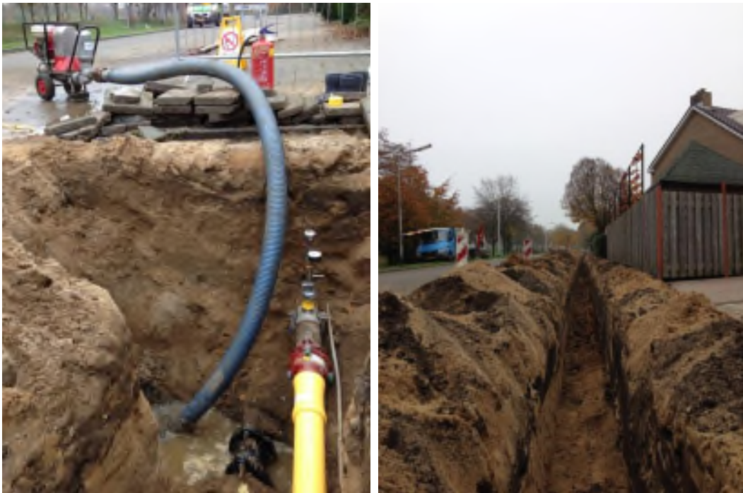
FIG. 2.6. WERKZAAMHEDEN BIJ VITENS, NIJMEGEN.
