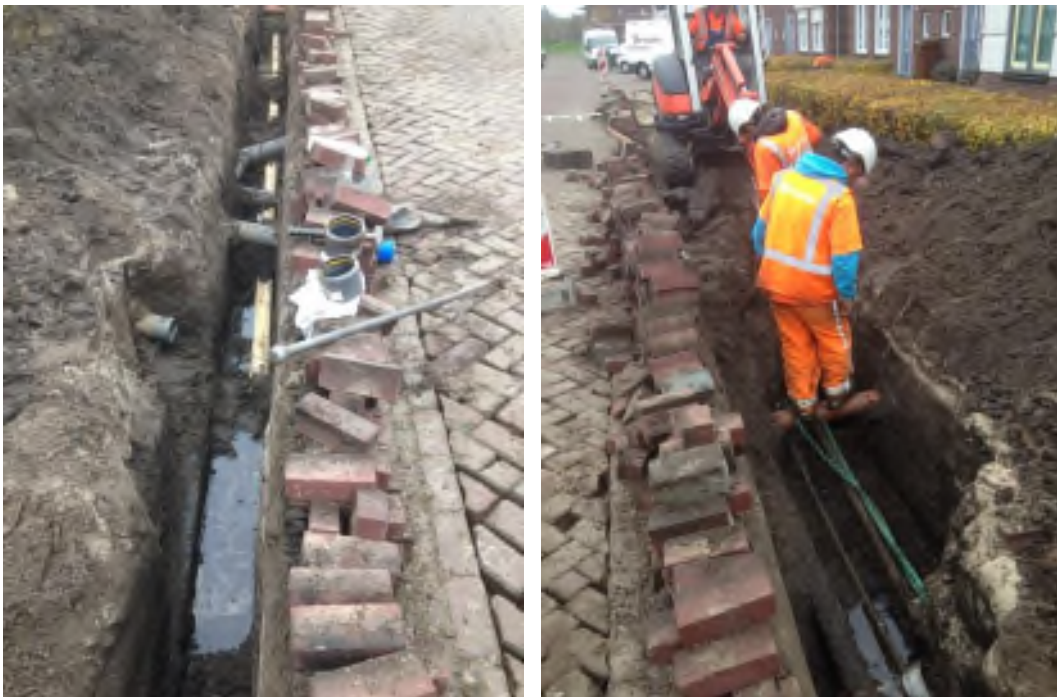
FIG. 2.3. WERKZAAMHEDEN BIJ BRABANT WATER, BREDA.
