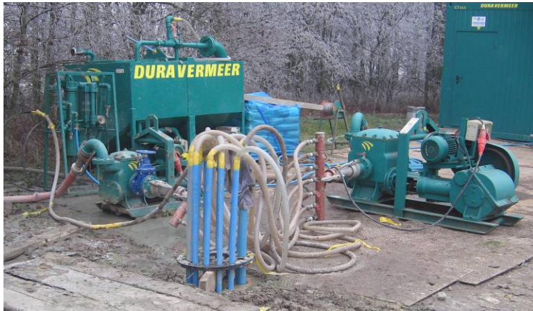
Figuur 21-6 Het schoonpompen van een waarnemingsput (Brabant Water).
