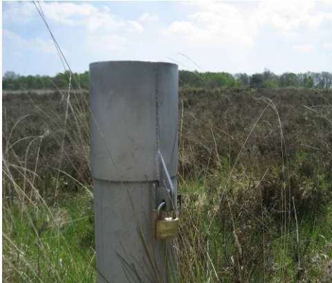
Figuur 21-7 Afwerking van een waarnemingsput door middel van een beschermkoker.
