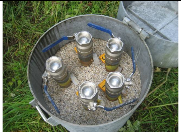
Figuur 21-10 Peilbuizen afgewerkt met kogelkraan.
