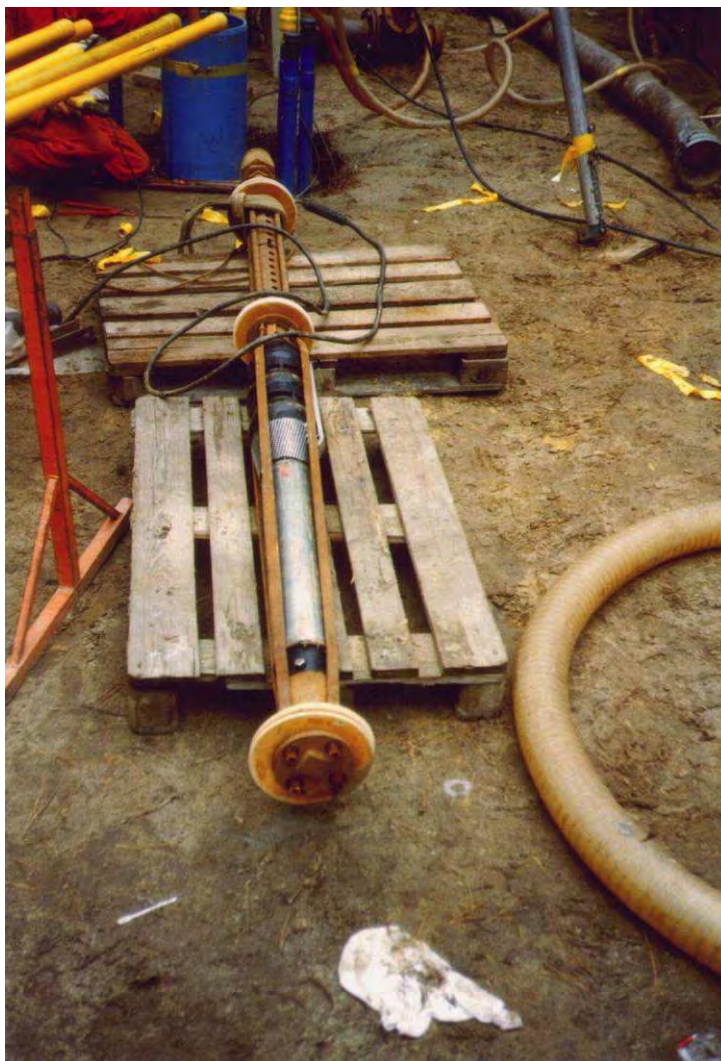
Foto 15-5 Een sectie-rondpompapparaat gebruikt voor regeneratie . Onderaan de pomp, bovenaan het deel waar het water terug wordt gebracht (C. van Rosmalen, Brabant Water)
