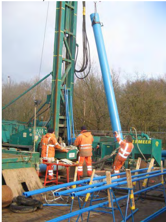
Figuur 11-9 Inbouwen pompput (foto Carl van Rosmalen, Brabant Water)
