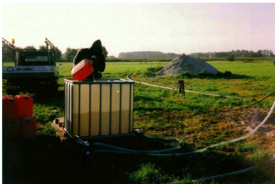
Foto 15-4 Regeneratie met chloorbleekloog, gereed maken van het regeneratiemiddel (C. van Rosmalen, Brabant Water)
