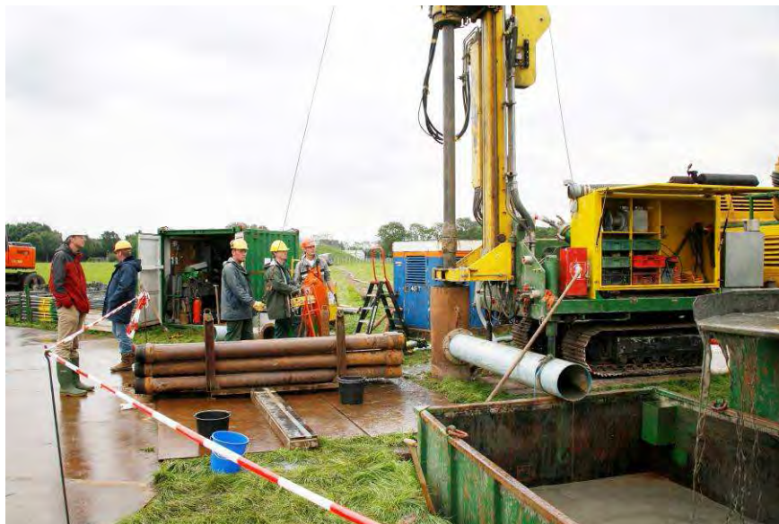
Foto 11-1 Uitvoering van een boring (foto Carl van Rosmalen, Brabant Water)
