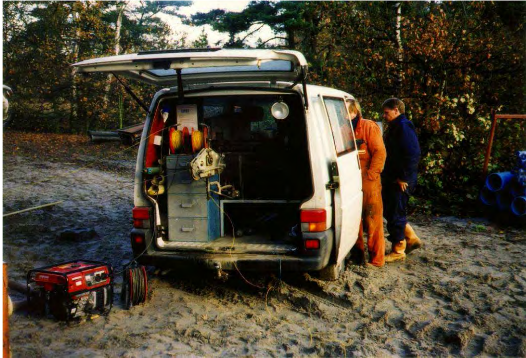
Foto 11-2 NITG-TNO op locatie voor een geofysische boorgatmeting (C. van Rosmalen, Brabant Water)
