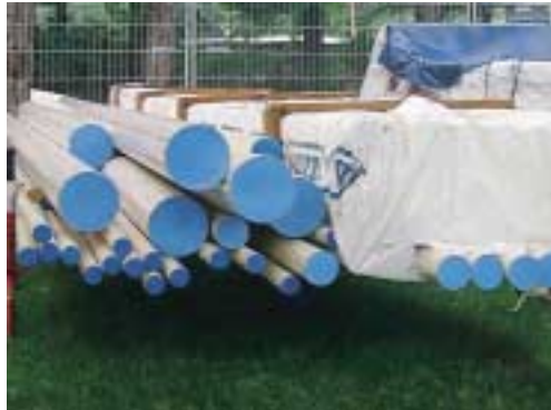
Afb. 5 Opslag van leidingen (foto: Brabant Water)
