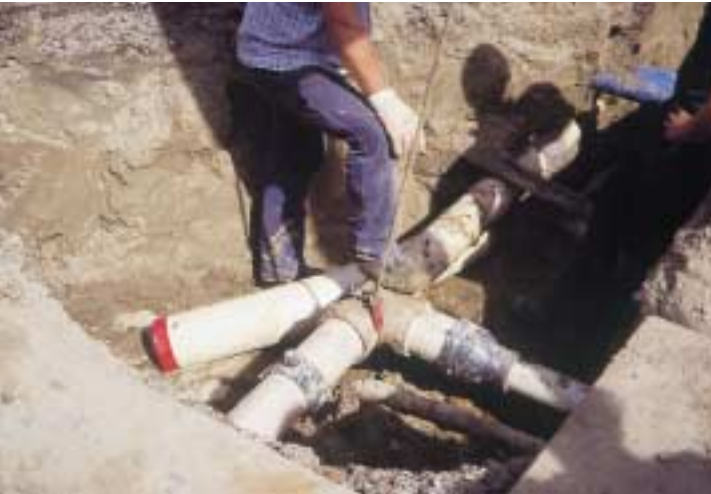
Afb. 6 Houd leidingdelen en hulpstukken zo lang mogelijk afgedopt, bij voorkeur tot in de sleuf (foto: DELTA)
