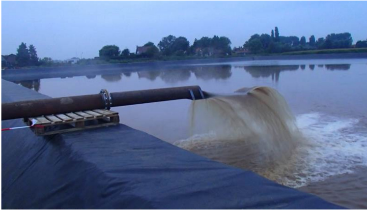
FIGUUR 2-3 TIJDELIJK OPSLAG VAN FORMATIEWATER BIJ PUTONTWIKKELING
