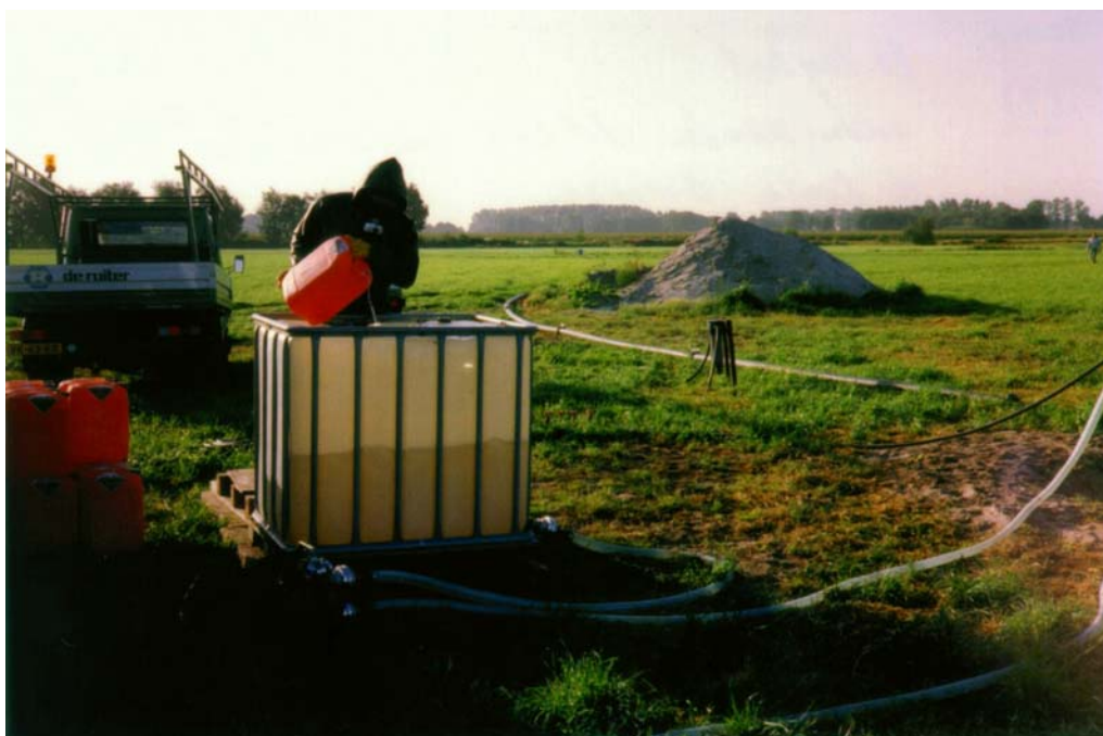
Foto 15-4 Regeneratie met chloorbleekloog, gereed maken van het regeneratiemiddel (C. van Rosmalen, WOB)
