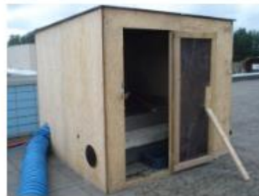
Foto 4 Werktent of constructie ten behoeve van een hygiënische zone buiten een gebouw (foto's PWN).
