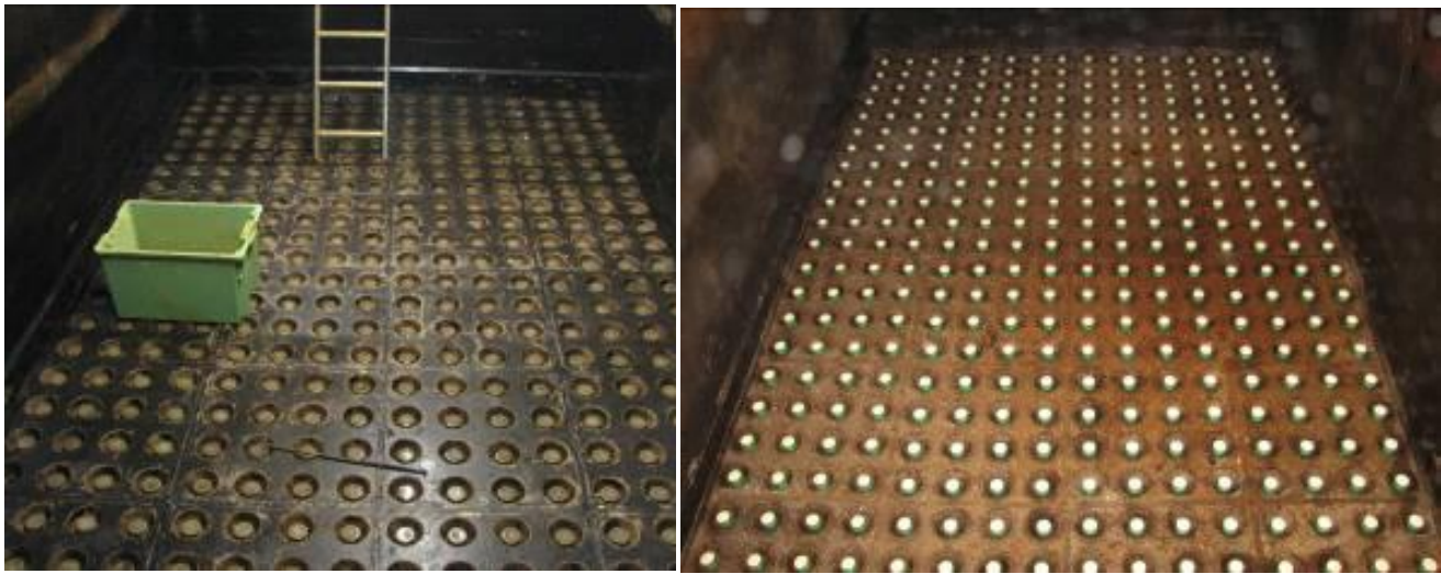
Foto 2 Werkzaamheden in risicoklasse IV: vervangen van spoeldoppen in een snelfilter op de locatie Breehei (foto's WML).
