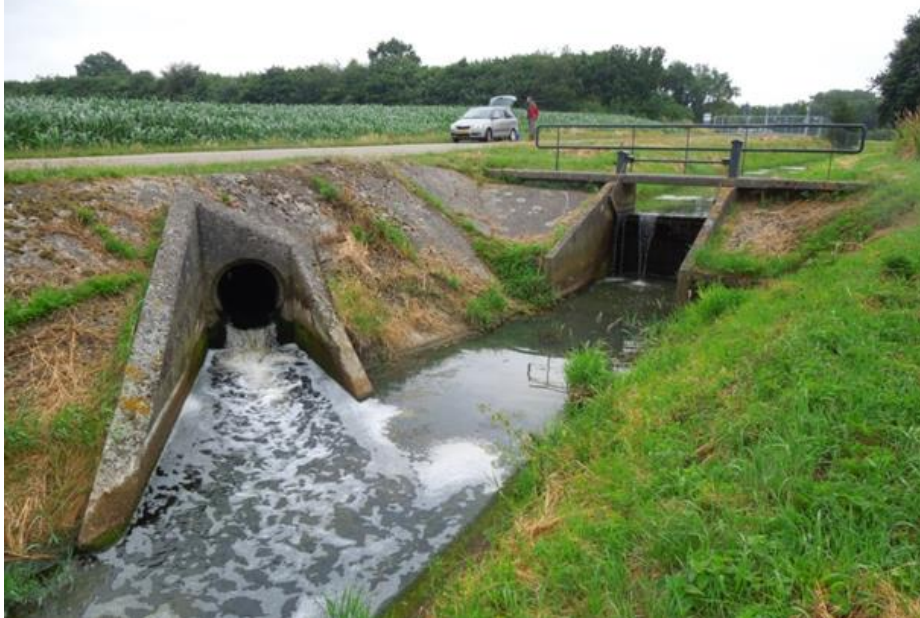
Hergebruik van effluentdeelstroom voor sub-irrigatie van een maisperceel bij rwzi Haaksbergen. Let op het verschil tussen de effluentlozing en de 'natuurlijke' afvoer.
