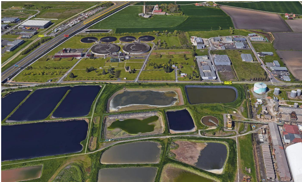
FIGUUR 3-11 OVERZICHT VAN DE RWZI VAN CLERMONT FERRAND (LINKSBOVEN), DE SUIKERFABRIEK (RECHTSONDER) EN DE TUSSENGELEGEN LAGUNES. DE GEIRRIGEEERDE AKKERS LIGGEN RECHTSBOVEN DE LOCATIE
