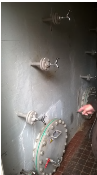
Monsternamen van water tijdens en na filtratie bij ps. De Meern (links). Analyse van water- en grindmonsters op microbiologische en chemische parameters (rechts).
