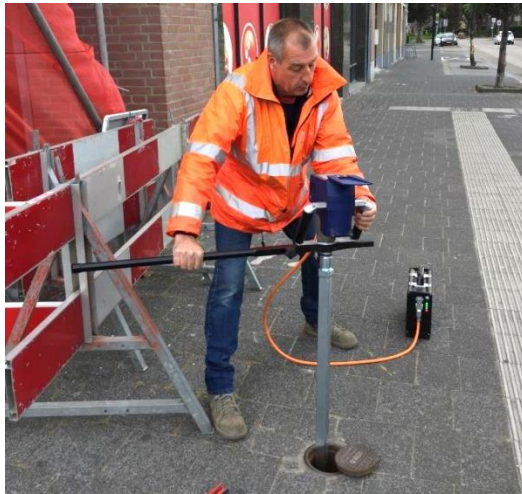
FIGUUR 4-2 EEN MONTEUR BEDIENT DE AIG-AFSLUITERSLEUTEL OM HET DRAAIMOMENT EN AANTAL SLAGEN VAN EEN AFSLUITER TE METEN.
