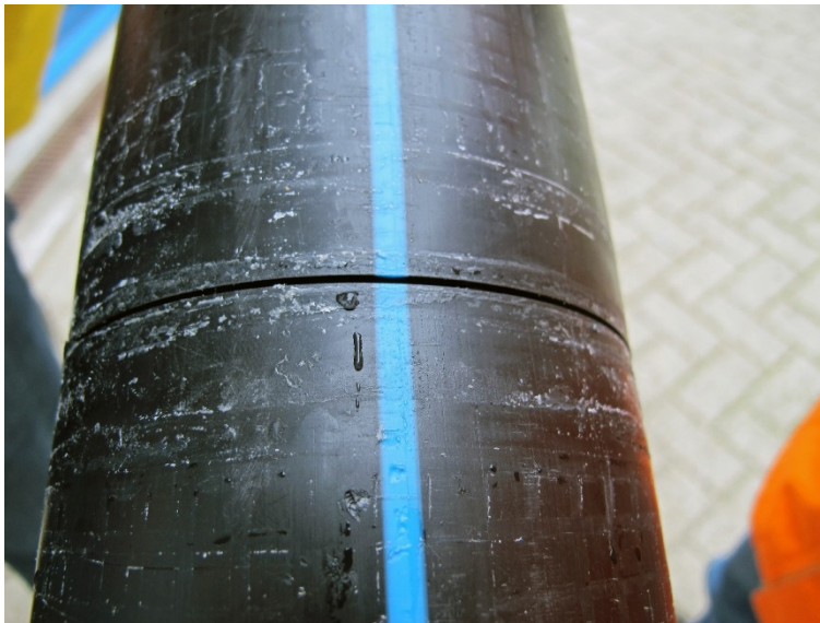
Figure 3.4 Resulting cut ( https://www.oasen.nl/nieuws/Paginas/Fotoverslag-Oasen-doet-test-met-mes-afsluiter-voor-waterleidingen-Artikel.aspx )
