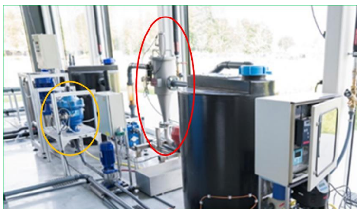
Afbeelding 3. Grof 250 \mu m- (rode cirkel) en zelfreinigend 25 \mu m-filter (gele cirkel) die zijn gebruikt tijdens SW-RO onderzoek
