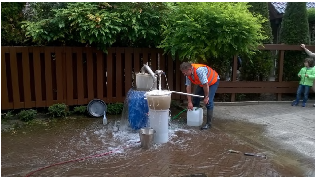
FIGUUR 2. SPUIOPSTELLING IN 'S-GRAVENDEEL. DE LEIDING VAN DE 90%-UITGANG IS VERLENGD EN KOMT IN HET BLAUWE VAT ONDER HET WATEROPPERVLAK UIT.
