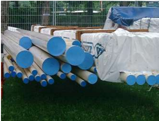
Foto's bij onderdeel 4 van checklist 3.5 Bescherming van leidingmaterialen tijdens opslag op de werklocatie.
