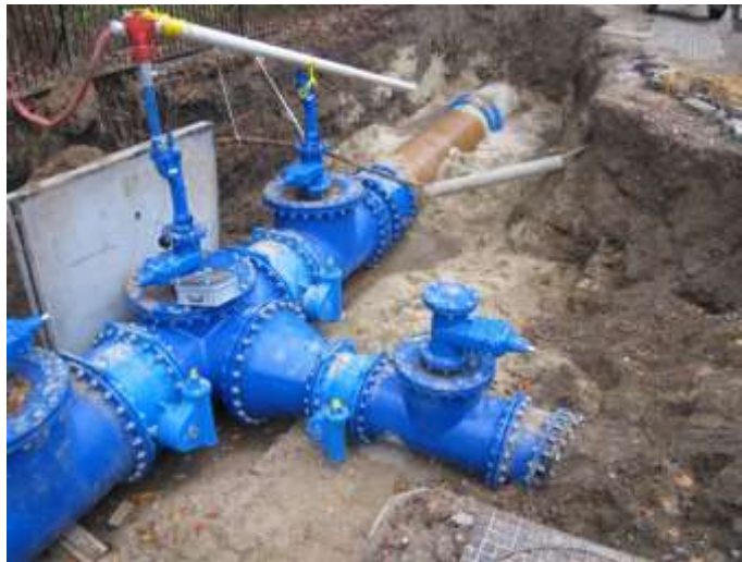
Foto bij onderdeel 6 van checklist 3.6 Aanleg van een leiding.
