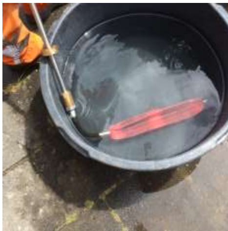
Foto bij onderdeel 3 van checklist 3.6 het segmenteren van een leiding).
