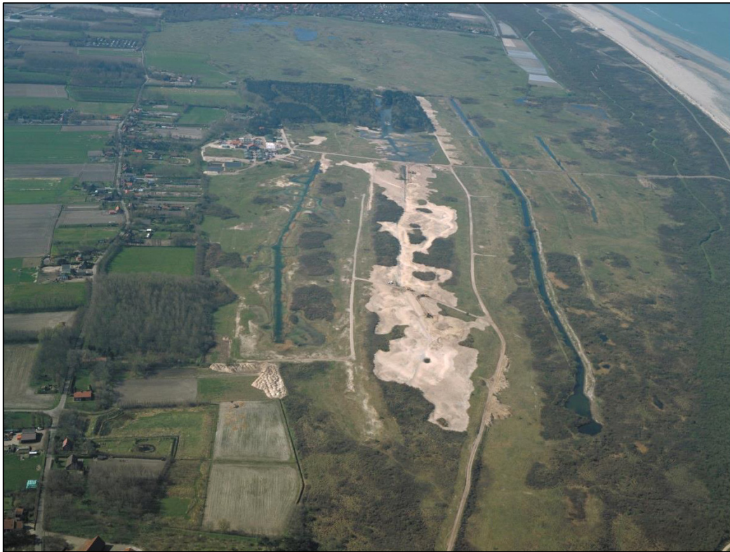
Foto 2-2: Luchtfoto van de Oostduinen tijdens de herinrichtingswerkzaamheden in het infiltratiegebied.
