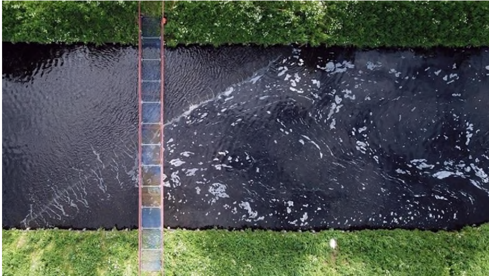
Bovenaanzicht van bellenscherm met de buis diagonaal in het water (en een brug over het kanaal) | foto: Hoogheemraadschap Hollands Noorderkwartier
