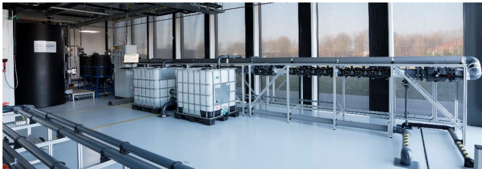
Proefinstallatie KIVODIS ( KWR in vitro distributiesysteem ) bij KWR
