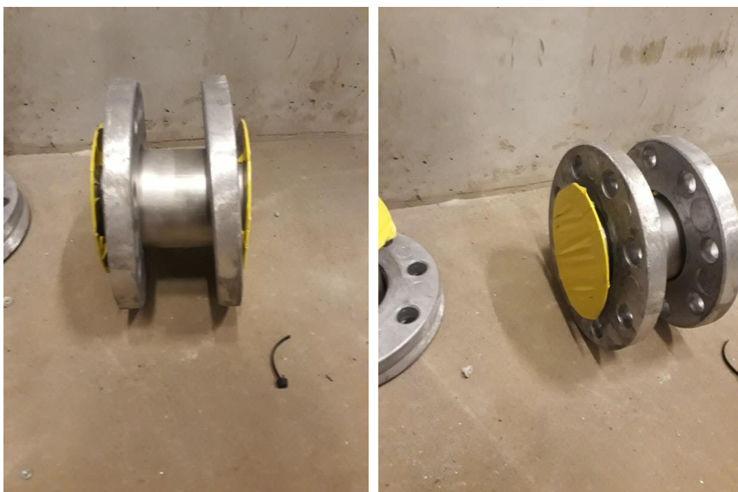
Figuur 3-10. Nieuwe, uitneembare leidingsegmenten voordat deze in de leiding worden teruggeplaatst. Het plastic afdek materiaal en de lijmresten worden verwijderd, waarna het
