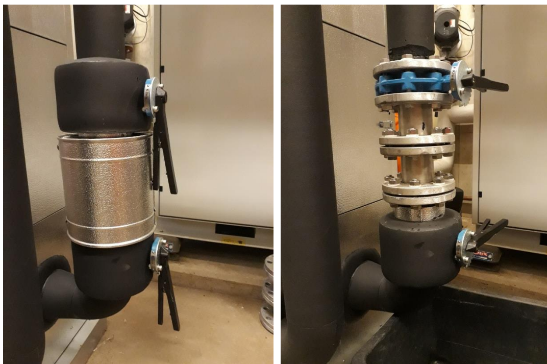
Figuur 3-8. Uitneembare leidingsegmenten voor bemonstering van de biofilm. Links is de pakking nog aanwezig, rechts is deze verwijderd en zijn twee van de drie segmenten zichtbaar. Het derde segment bevindt zich onder de onderste, zwarte pakking.
