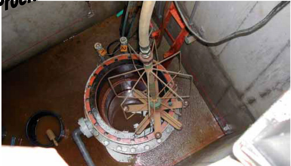
Regeneratie van een verstopte put met een hogedrukreiniger (foto: Brabant Water).
