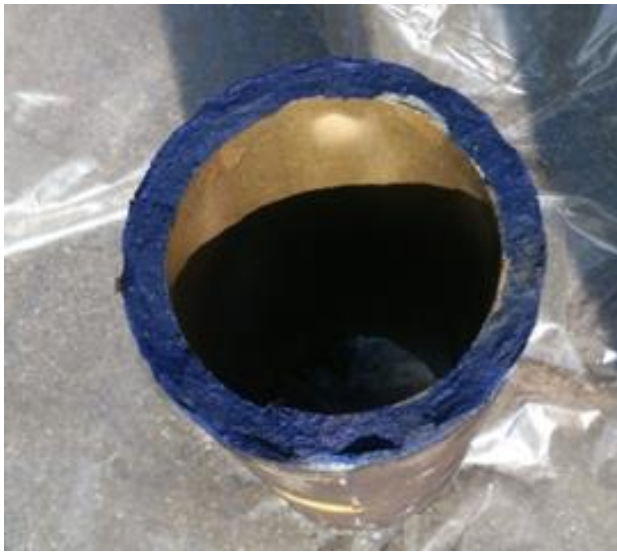
FIGUUR 2 EEN DESTRUCTIEVE TEST MET THYMOLFTALEÏNE OP AC BUISDELEN. DE BLAUWE KLEUR BETEKENT DAT DE WAND OP DEZE LOCATIE NOG CEMENT BEVAT; CEMENT DRAAGT BIJ AAN DE STERKTE VAN DE BUIS
