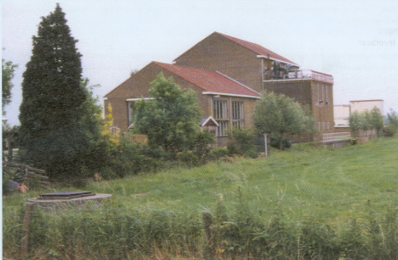
Pompstation Tull en 't Waal met op de voorgrond put 20.
