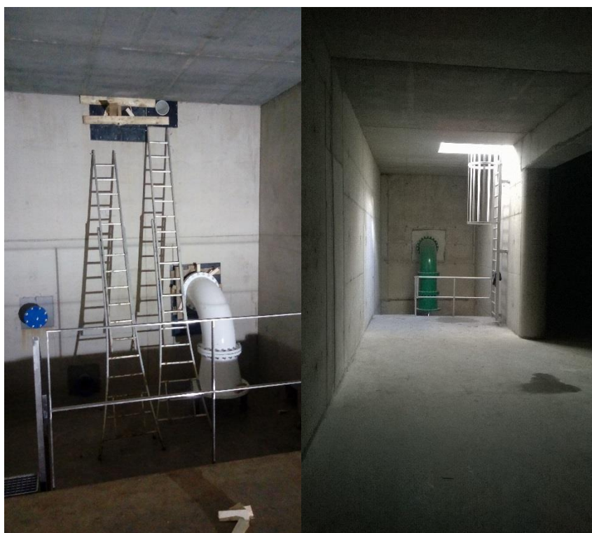
Foto 7 Zuigkuil in aanbouw (links) en afgewerkt (rechts) (foto's Pidpa).
