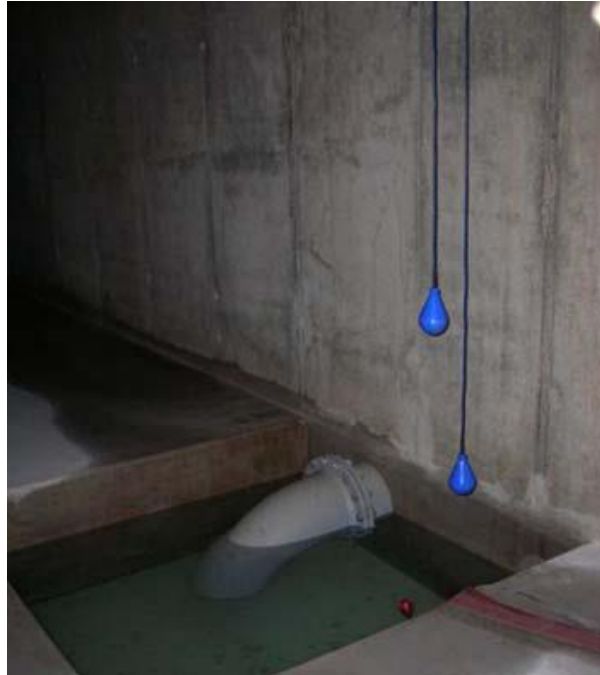
Foto 5 Zuilkuil met niveaumetingen (foto Vitens).
