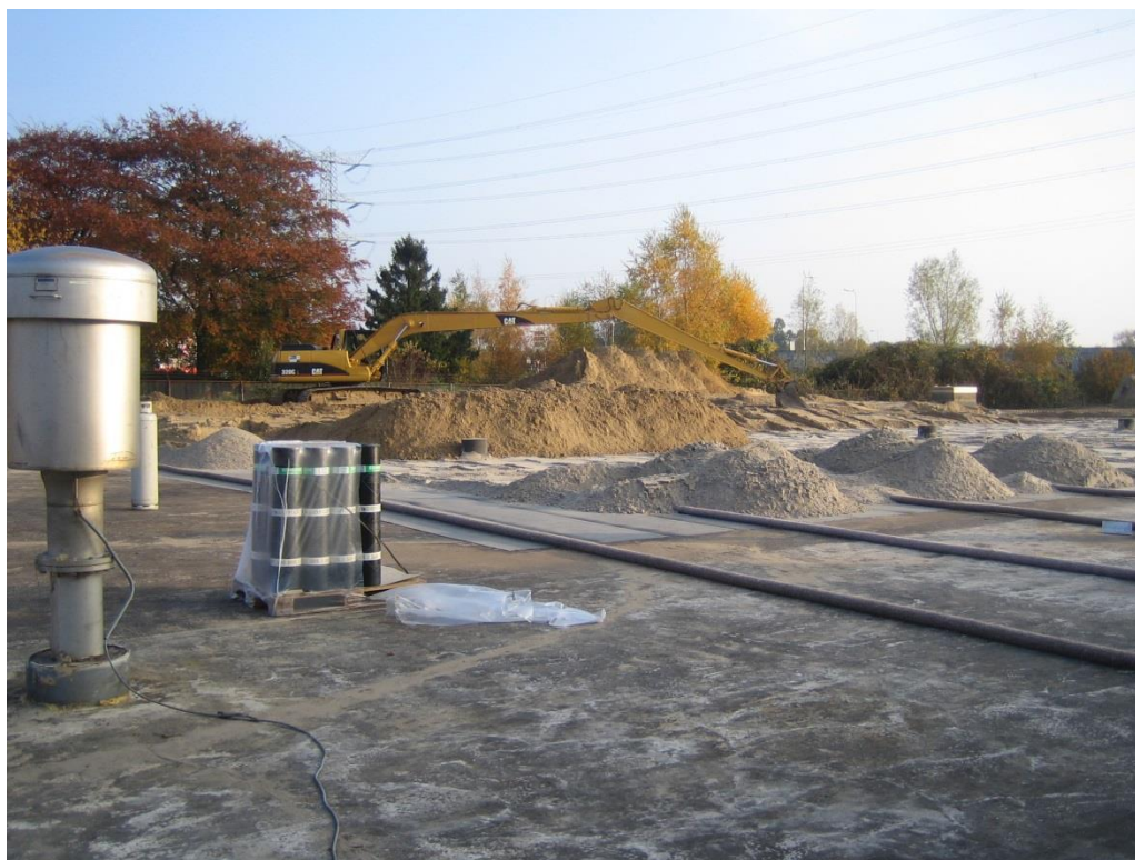
Foto 13 Dak van een reservoir bestaande uit dakbedekking (zand en grond moeten nog worden aangebracht) (foto Vitens).
