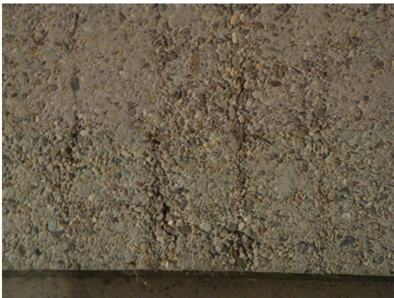
Foto 20 Oppervlakteruwheid beton.
