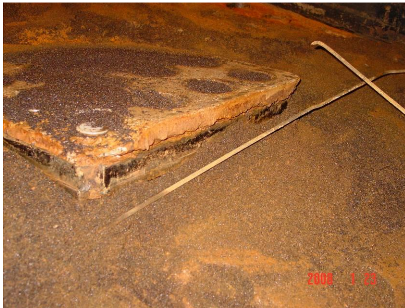
Foto 22 Beschadigde filterbodem.
