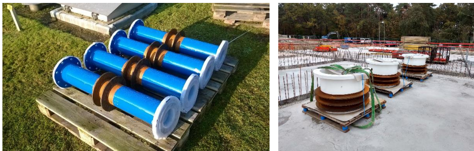
Foto 10 Nog in te storten doorvoerstukken op de het bouwterrein. De niet-gecoate delen van de buitenbuiswand en de lek- en verankeringsflenzen zijn nog zichtbaar (foto's Pidpa).
