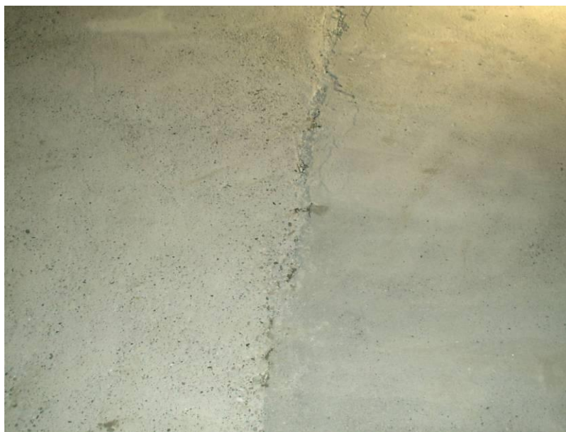
Foto 19 Onvlakheid ter plaatse van aangeheelde vloer.
