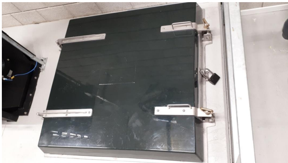
Foto 3 Volledig afsluitbaar RVS toegangsluik (foto Evides Waterbedrijf).
