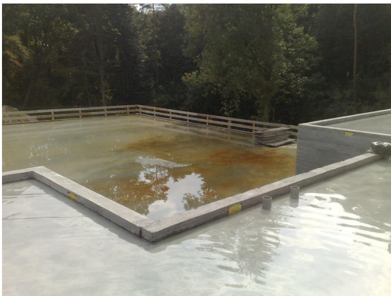
Foto 14 Testen waterdichtheid van het dak van een drinkwaterreservoir (foto Evides Waterbedrijf).
