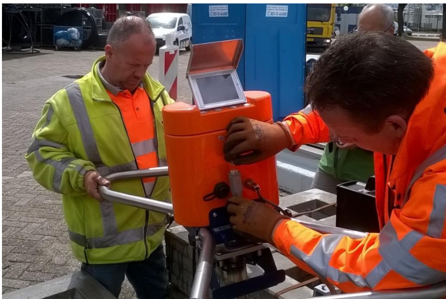
Figuur 2 Automatische afsluitersleutel met registratie gegevens.
