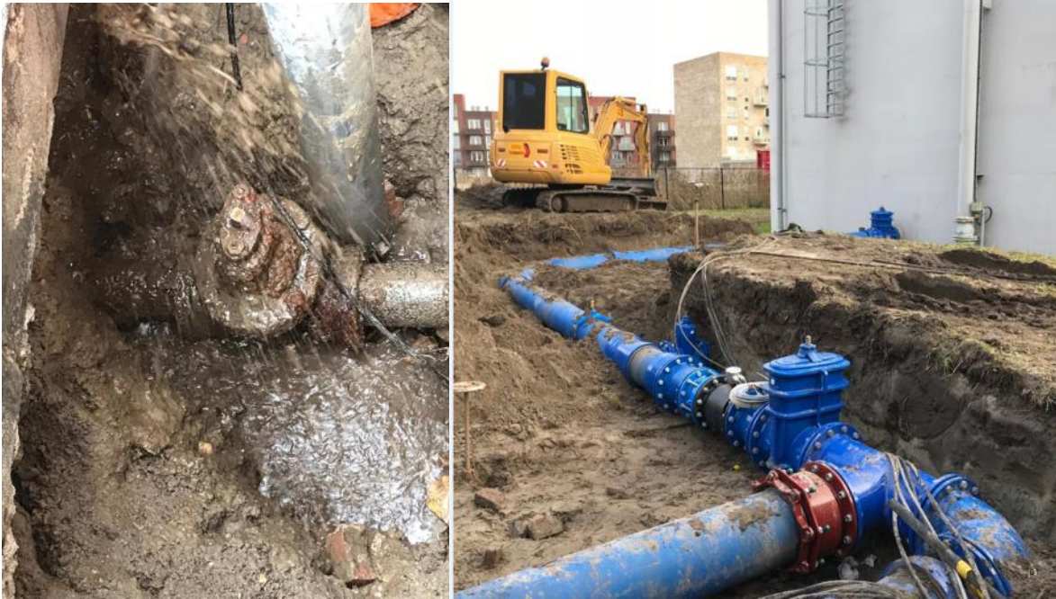
Oude afsluiter en nieuw aangelegde afsluiter, Dunea
