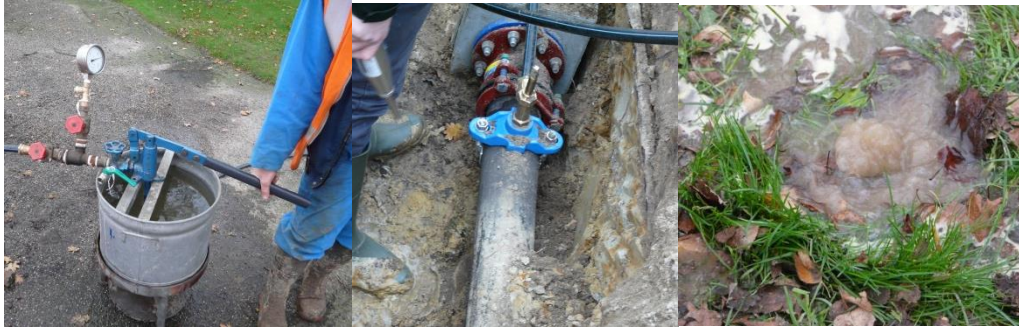
FIGUUR 5-2 UITVOERING VAN DE DRUKPROEF: DE HANDPOMP EN DE DRUKMETER (LINKS), DE AANSLUITING OP DE LEIDING MET DE FLENS EN DE STEPELING (MIDDEN) EN HET LEK NADAT DE LEIDING WEER 'OP DRUK IS GEZET' (RECHTS).
